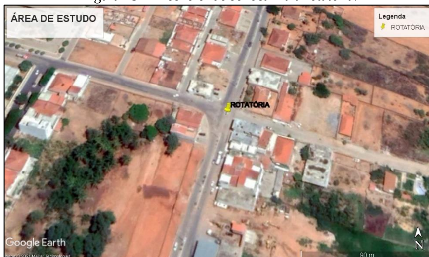
Figura 15 – Trecho onde se localiza a rotatória.
