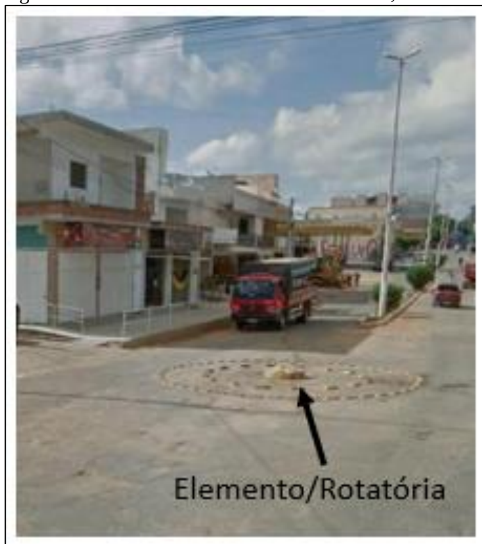
Figura 26 – Trechos onde se localiza a rotatória, street view .
