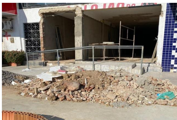
Figura 14- comercial no bairro Centro.
