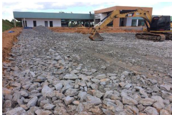
Figura 2- Terraplanagem com uso de rachão.
