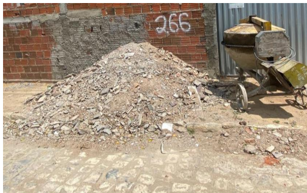
Figura 10- Residência localizada no bairro do Poção
