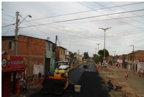
Figura 6- Execução do revestimento asfáltico
