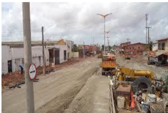
Figura 5- Execução da base em BGS reciclado.
