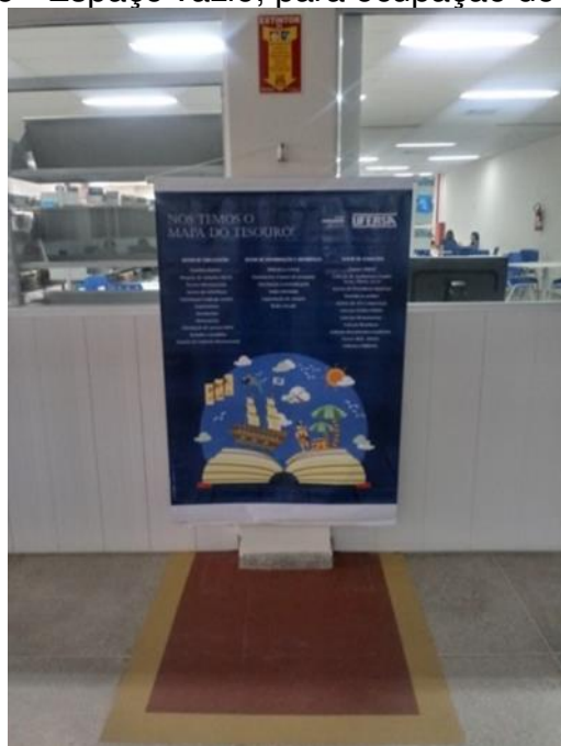
Figura 5 - Espaço vazio, para ocupação de extintor.
