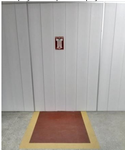
Figura 7 - Espaço vazio para ocupação de extintor.
