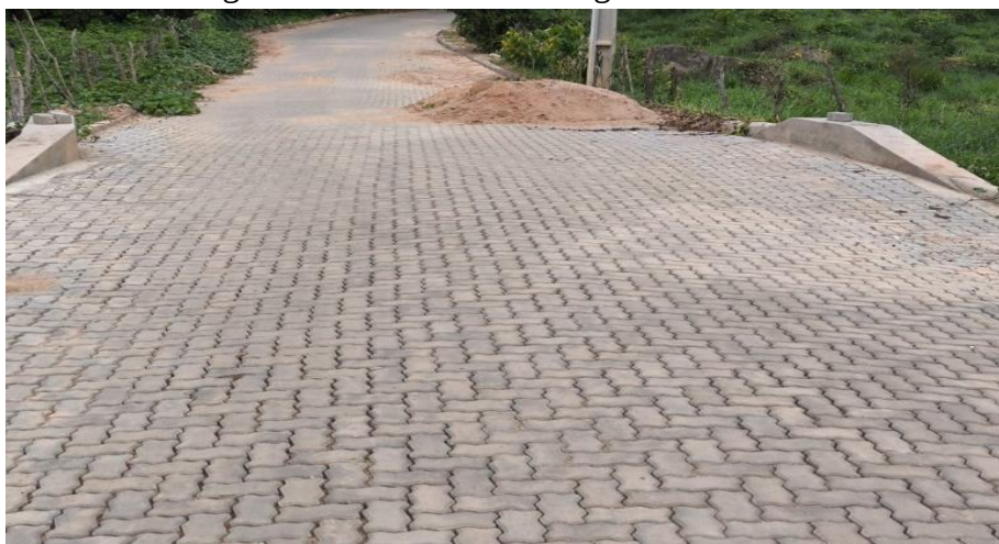
Figura 27 - Assentamento regular dos blocos
