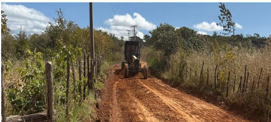
Figura 16 - Início da terraplenagem
