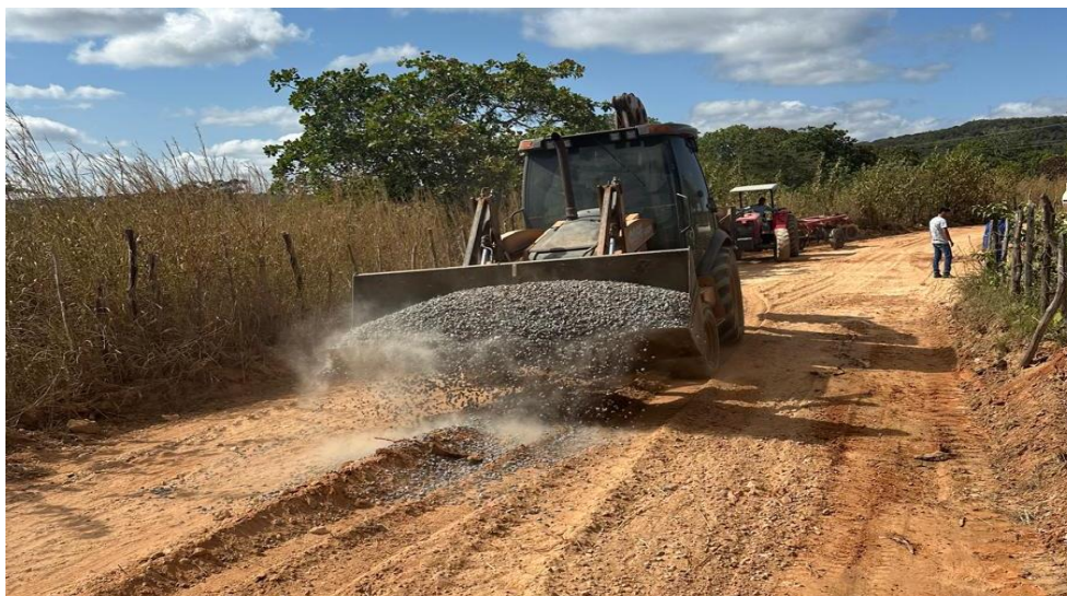
Figura 18 - Espalhamento da brita
