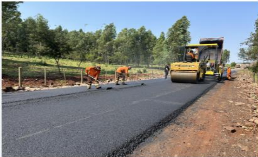
Figura 2 - Processo de recapeamento com asfalto
