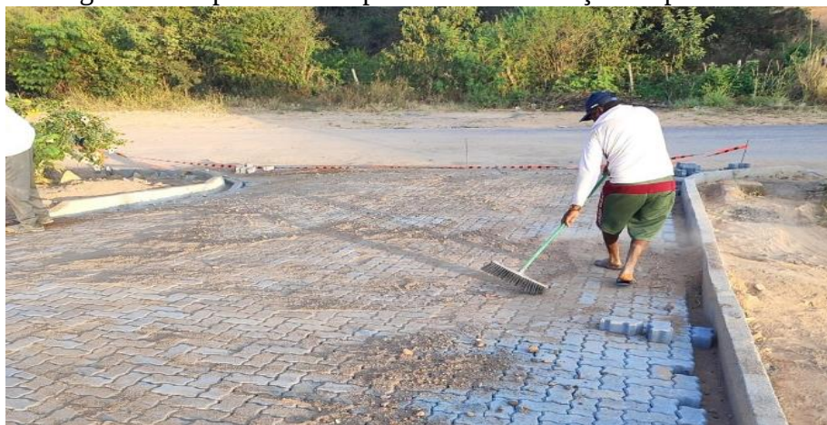
Figura 22 - Apresenta o espalhamento e varrição do pó de brita
