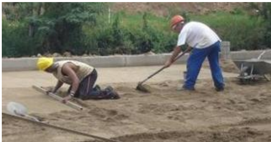
Figura 20 - Espalhamento e nivelamento da areia de assentamento
