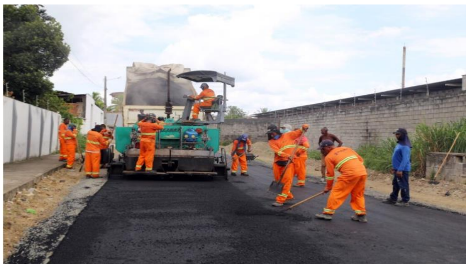
Figura 1 - Utilização da pavimentação flexível em Itabuna
