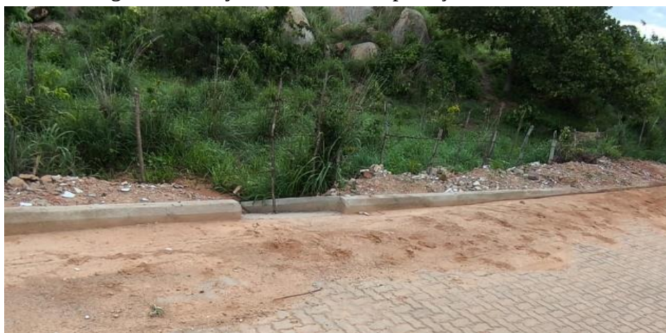
Figura 29 - Sarjeta com valeta de proteção dos aterros.
