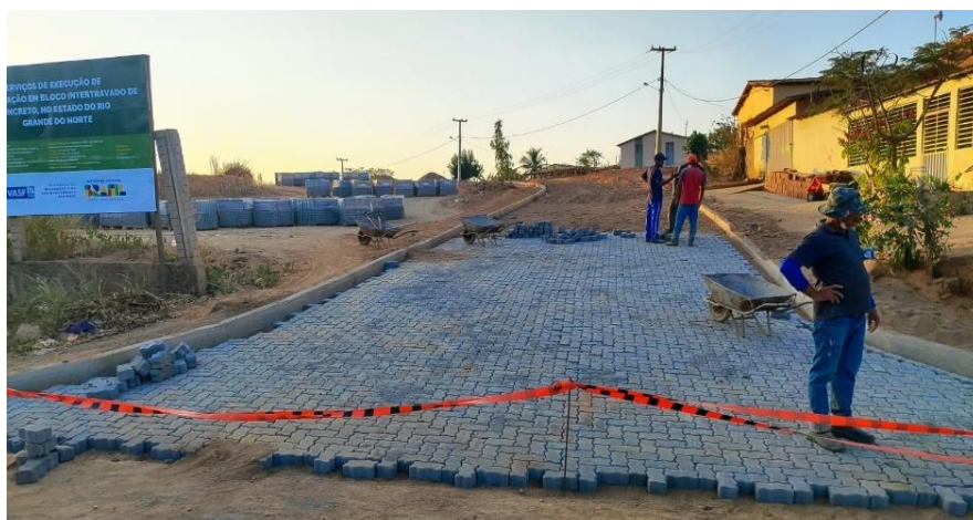
Figura 21 - Assentamento dos blocos na areia
