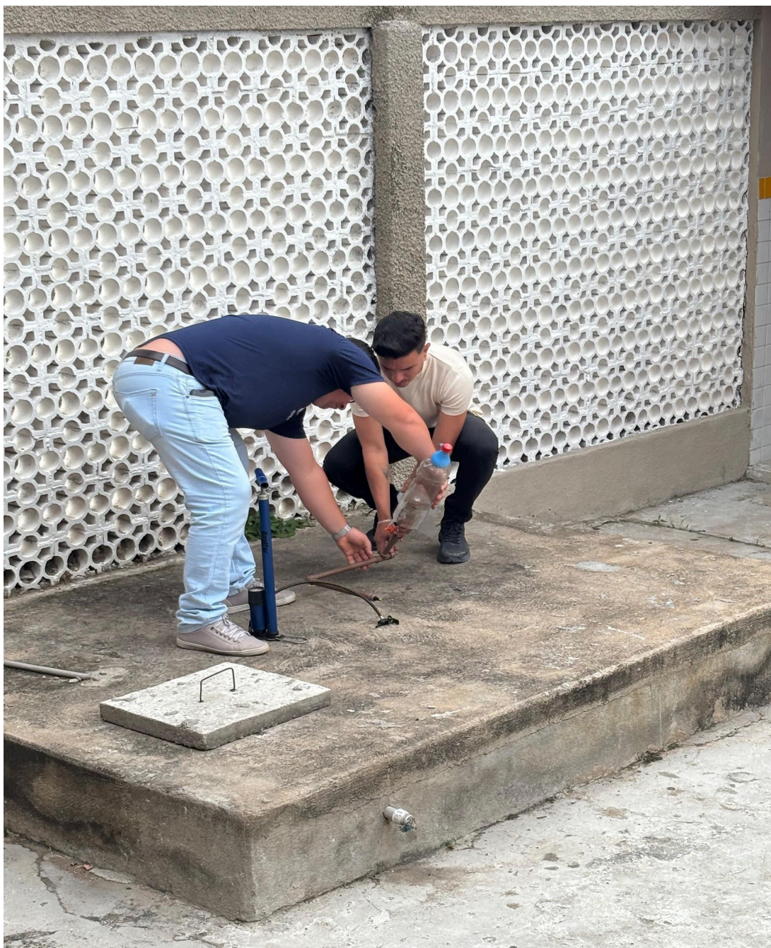
Figura 5 – Execução de lançamentos experimentais
