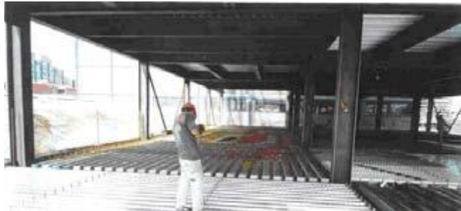
Imagem 01: construção não escorada
