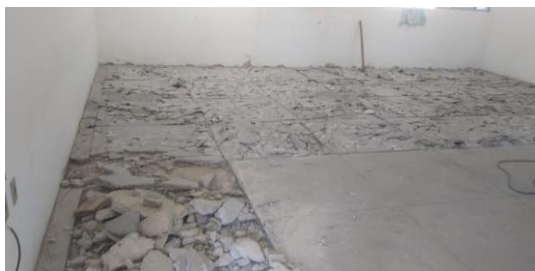
Figura 11. Remoção do piso granilite. Fonte: SIN (2019).
