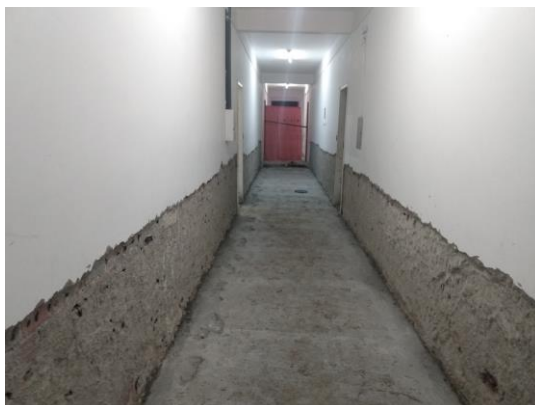
Figura 9. Remoção do reboco das paredes. Fonte: SIN (2019).
