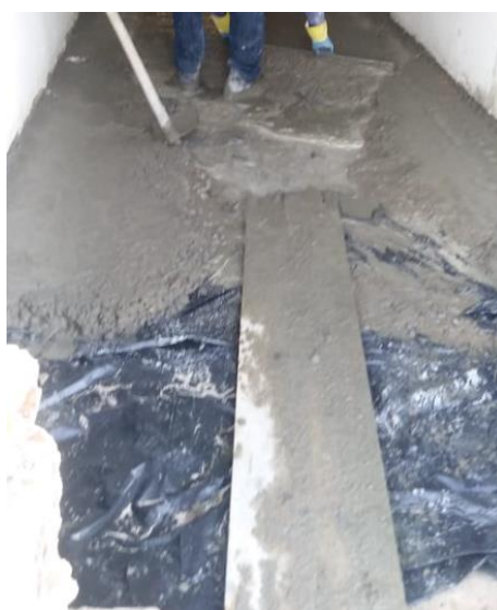
Figura 13. Utilização de lona na camada de assentamento. Fonte: SIN (2019).
