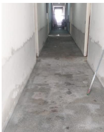
Figura 10. Reboco nas paredes. Fonte: SIN (2019).
