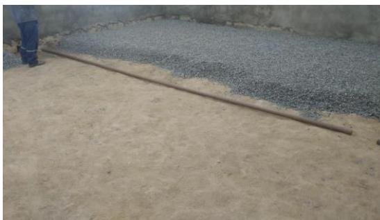
Figura 12. Remoção do piso granilite. Fonte: SIN (2019).
