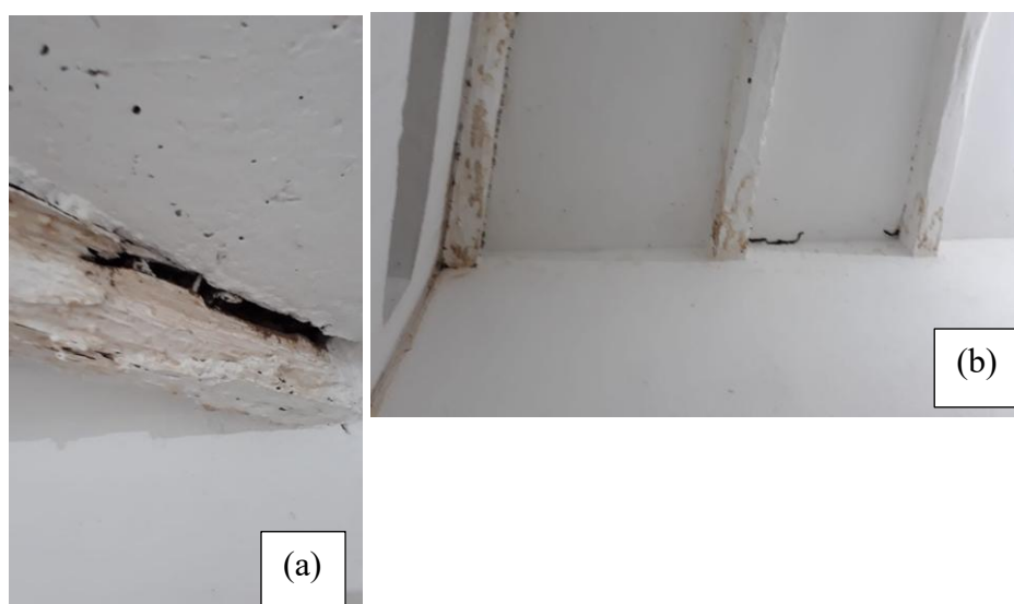
Figura 14- Infestação de cupins: (a) e (b) apresentam um ataque por agentes biológico em estruturas de madeira. Fonte: Elaborado pela Autora, (2025).
