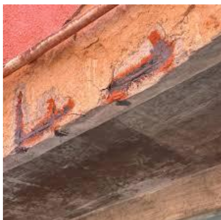
Figura 4- Ilustração de uma Corrosão em Armaduras.
