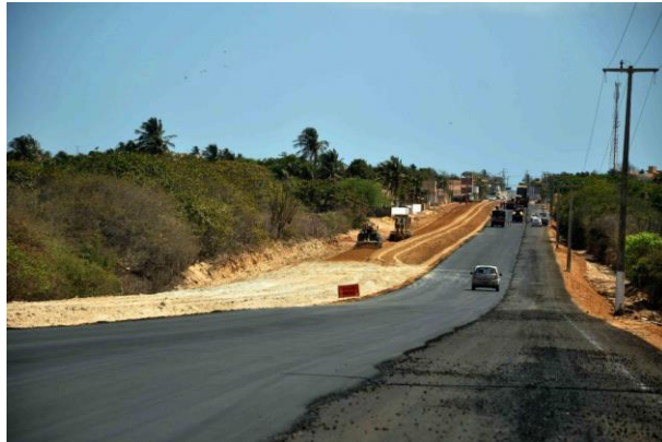
Figura 3: Trecho Final da Duplicação
