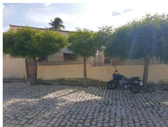
Figura 23 – Fachada Posterior da Escola
