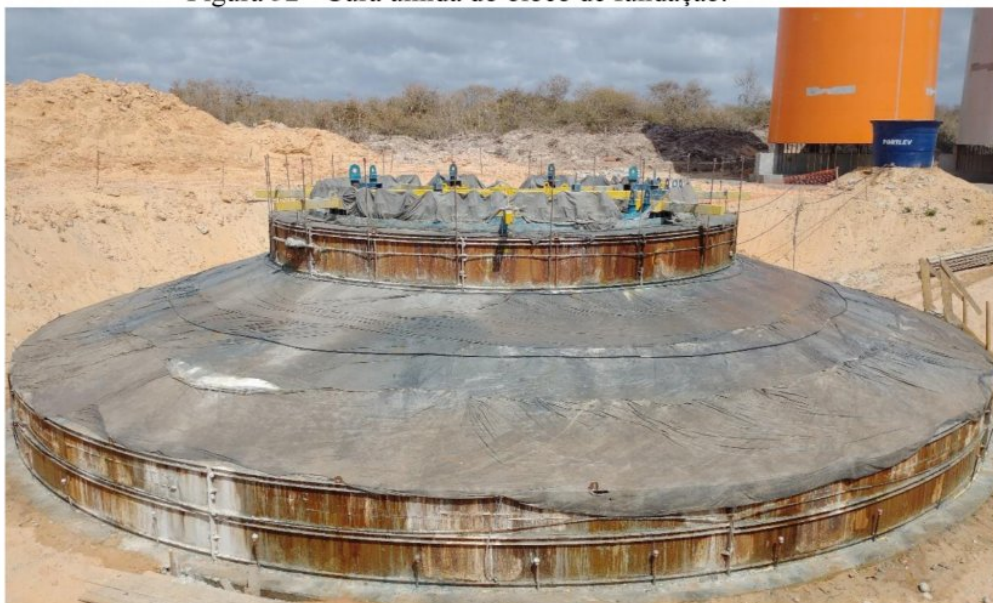
Figura 32 - Cura úmida do bloco de fundação.
