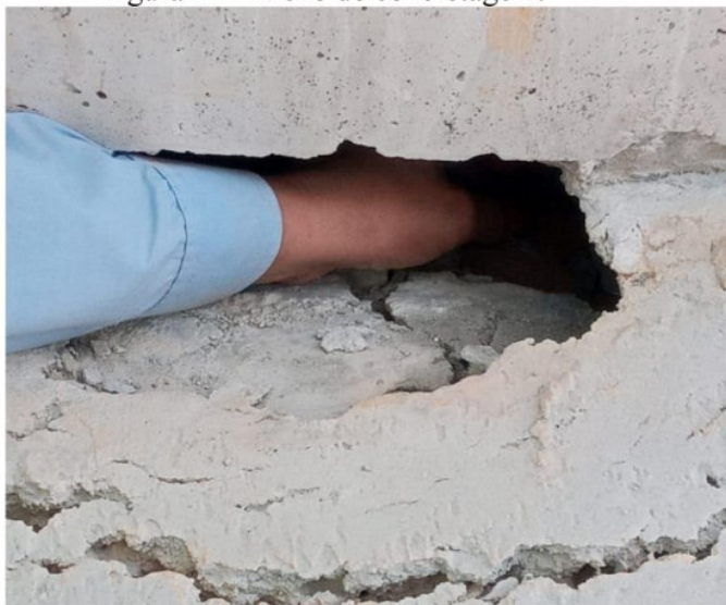
Figura 33 - Nicho de concretagem.
