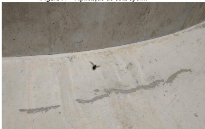
Figura 39 - Aplicação de cola epóxi.
