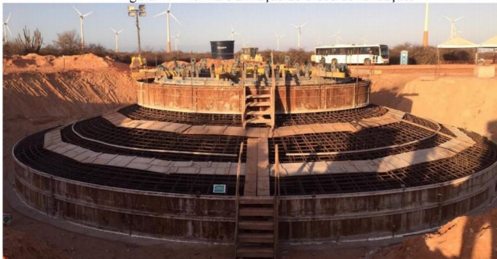
Figura 20 - Fôrma e armação do bloco de fundação.
