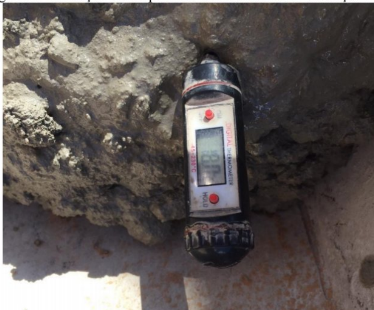
Figura 26 - Aferição da temperatura do concreto antes do lançamento.
