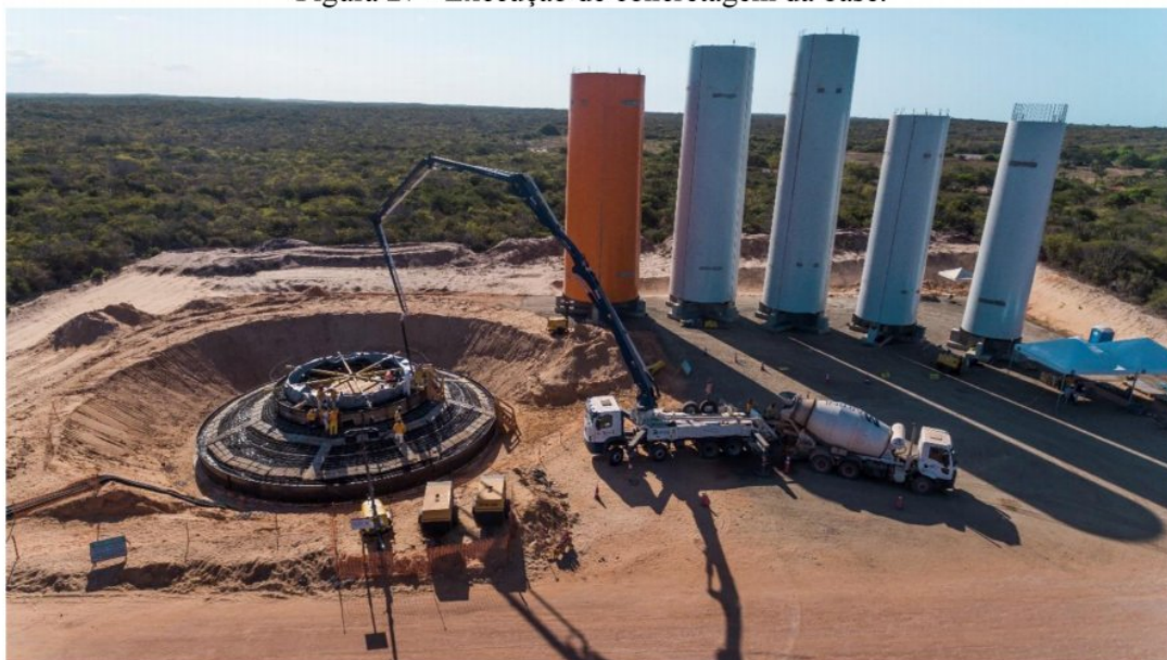
Figura 27 - Execução de concretagem da base.
