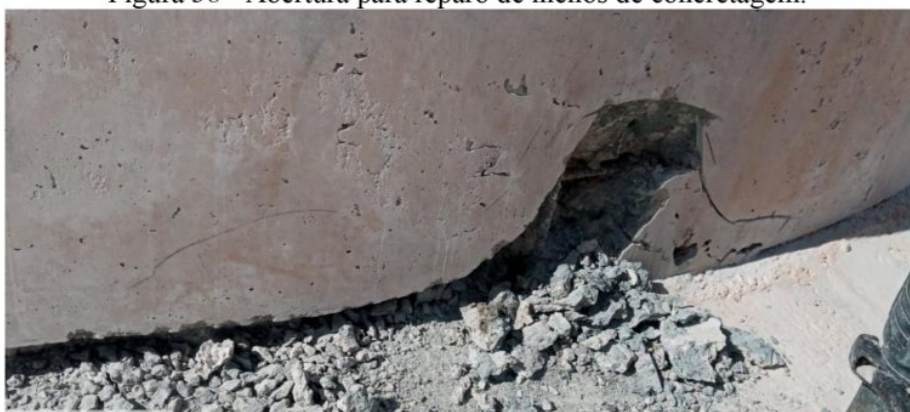
Figura 38 - Abertura para reparo de nichos de concretagem.
