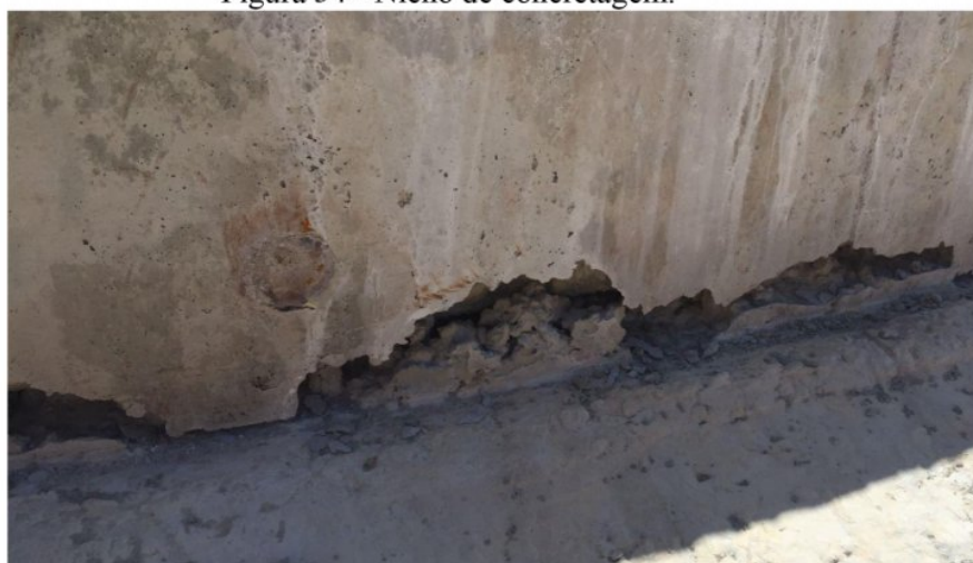
Figura 34 - Nicho de concretagem.
