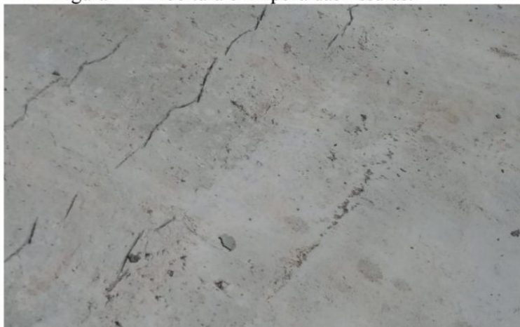
Figura 37 - Abertura e limpeza das fissuras.
