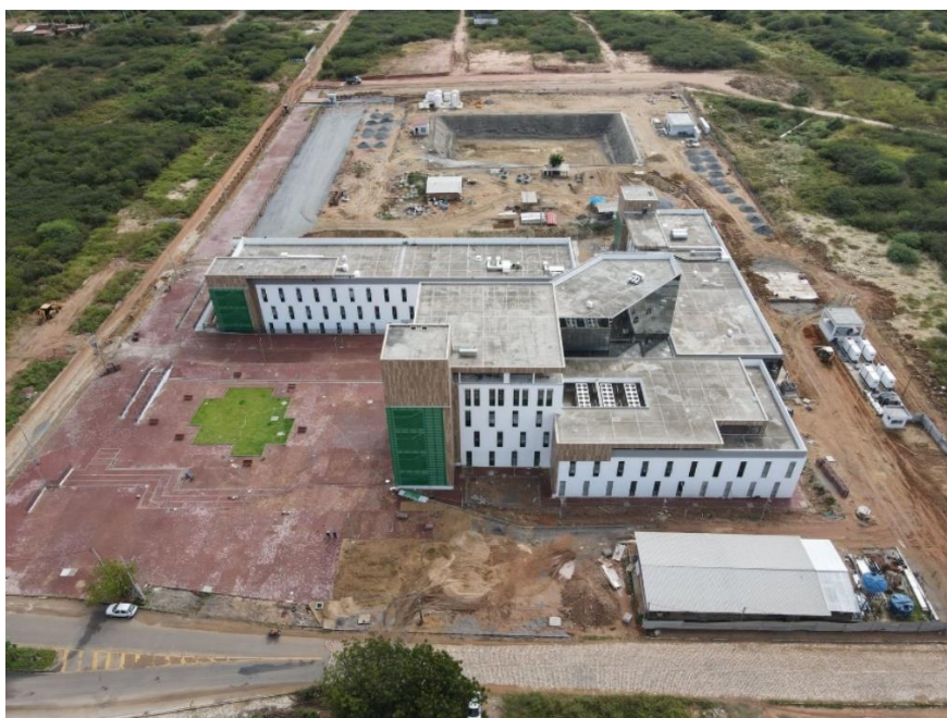
Figura 15: Vista aérea da obra.
