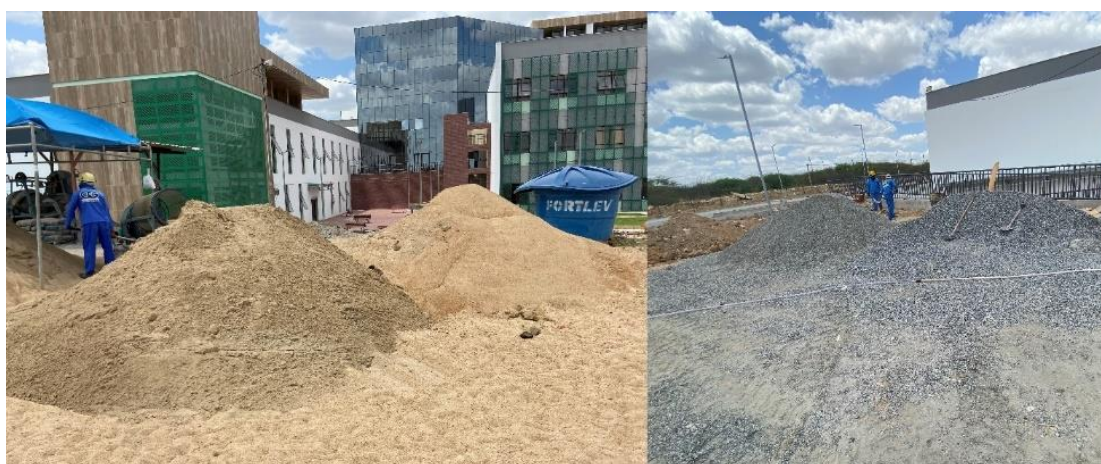
Figura 17: Armazenamento de areia e brita.
