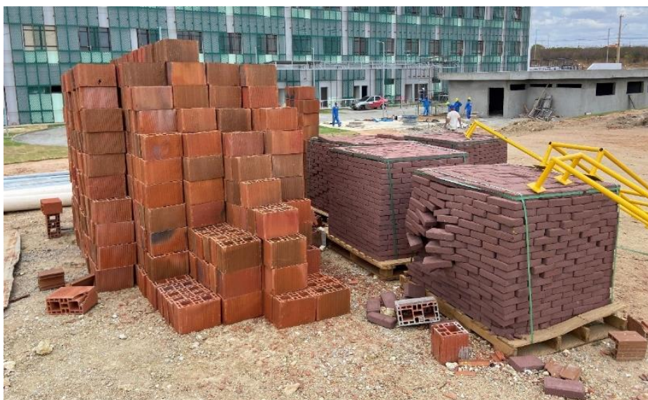
Figura 23: Armazenamento de tijolos e blocos de pedra.
