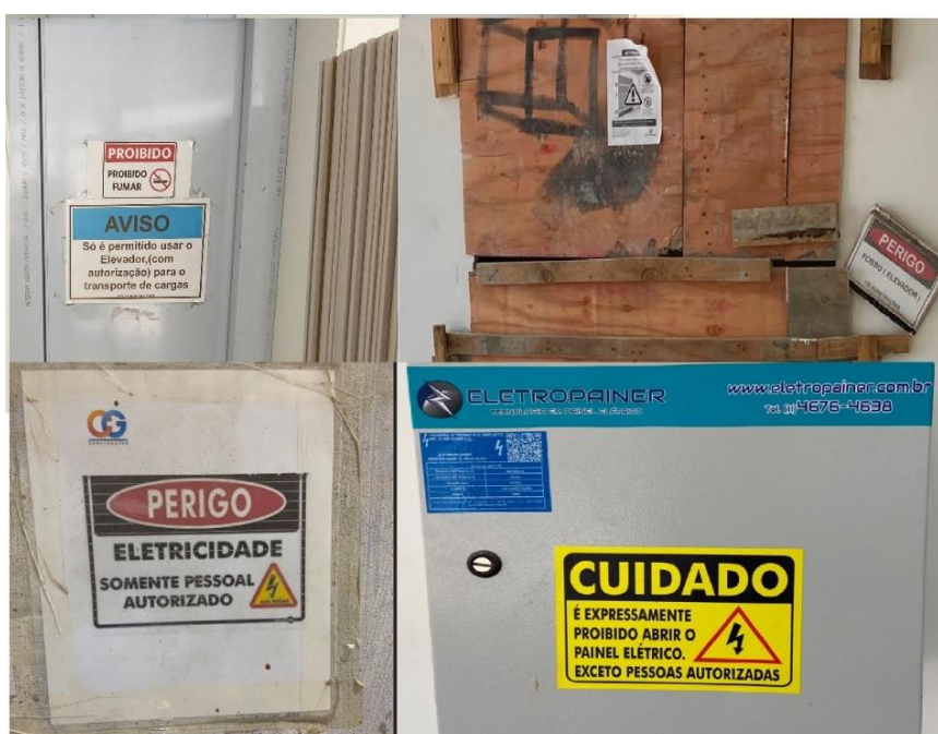
Figura 37: Placas de sinalização encontradas no canteiro de obras.
