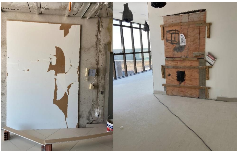
Figura 32: Fechamento do vão de acesso a caixa do elevador.
