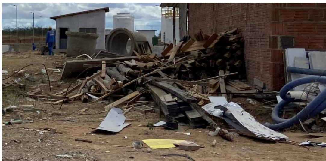
Figura 22: Armazenamento de madeira para reutilização.
