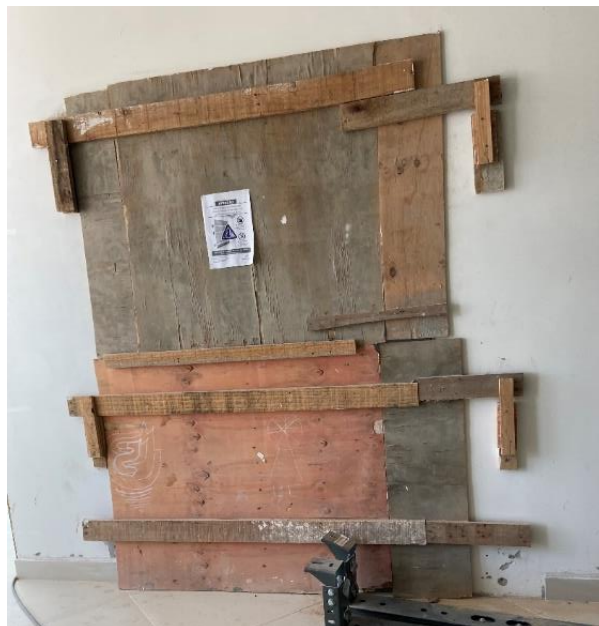
Figura 3: Abertura para caixa do elevador fechada.
