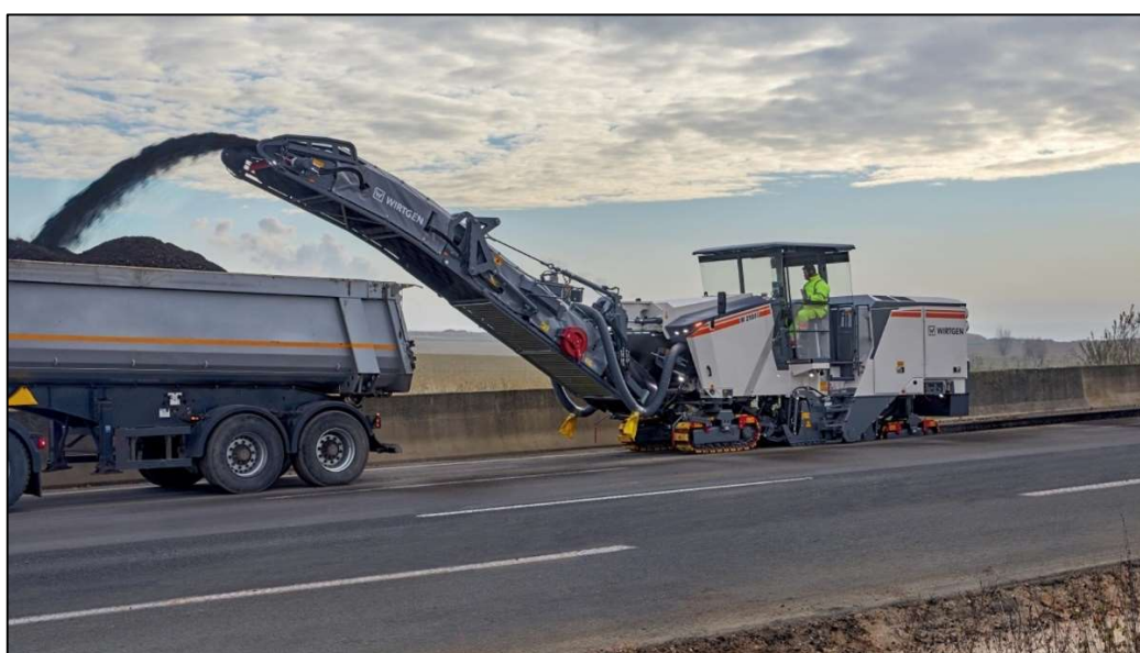
Figura 5: Fresadora a frio em operação
