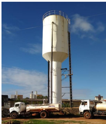
Figura 3. Estação elevatória no bairro Santo Antônio. (Fonte adaptada: Celular Asus Zefone, 2019)
