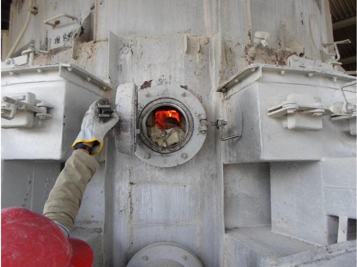
Figura 9 - Calcário sendo calcinado na zona de queima do forno AZBE
