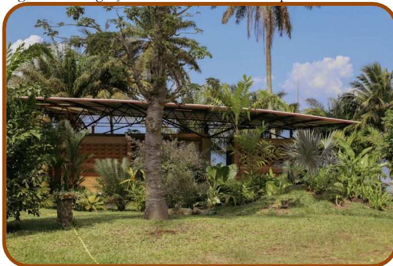
Figura 9 – Integração com o entorno natural por meio de aberturas.
