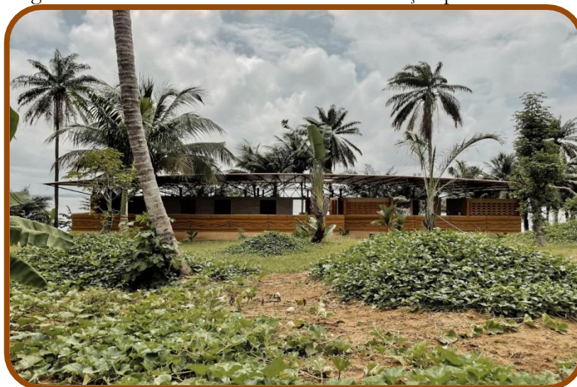
Figura 8 – Estrutura leve e sistema de ventilação passivo.
