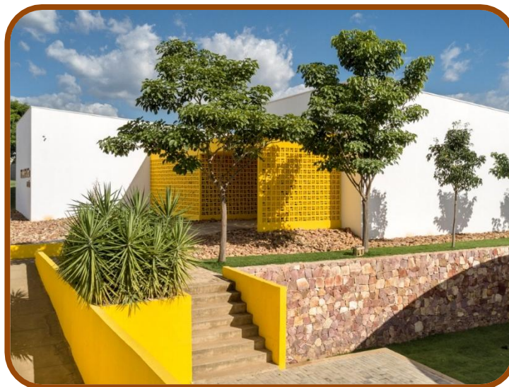
Figura 15 – Fachada marcada pelo uso do cobogó e cores como estratégias climáticas.
