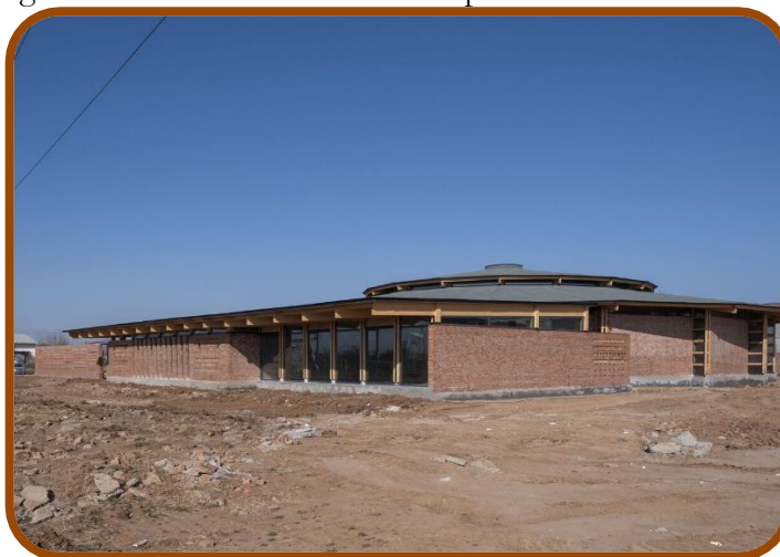
Figura 11 – Uso do vidro e vazios para conforto térmico e iluminação natural.
