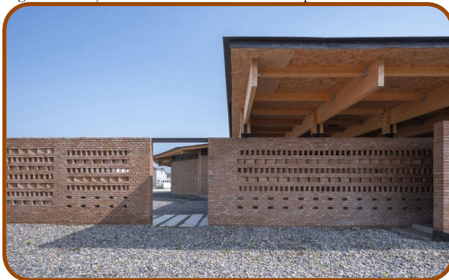
Figura 10 – Tijolo cerâmico como elemento expressivo e estrutural na fachada.
