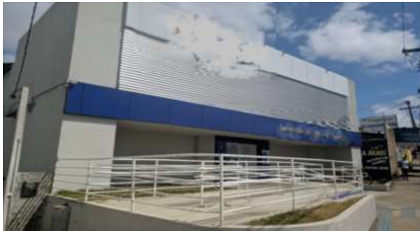
Figura 4 - Fachada da unidade A
