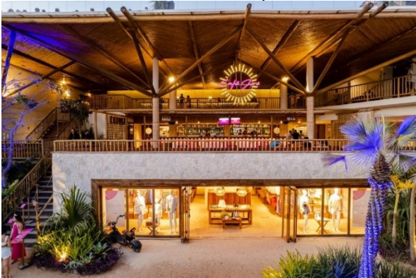
Figura 26. Fachada principal, com vista de lounge do bar e rooftop .
