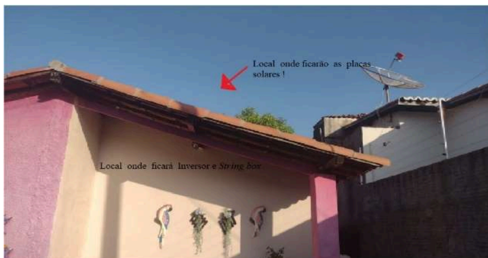
Figura 20-Locais de instalação das placas solares, inversor e string box
