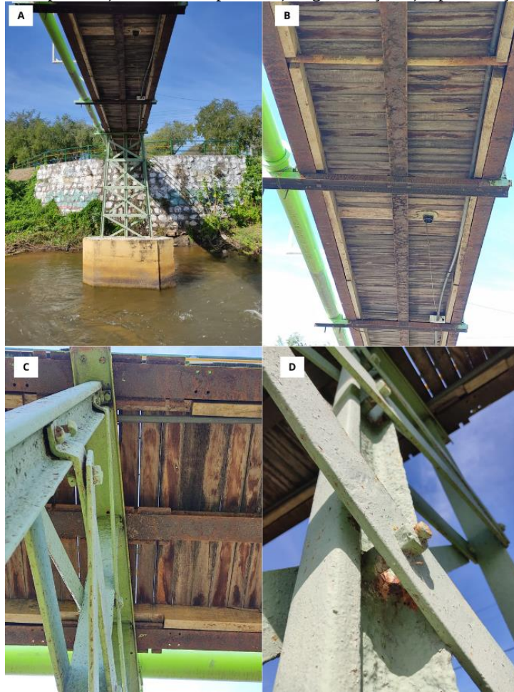
Figura 23: Parte inferior da ponte A) Extensão da ponte; B) Vigas de aço; C) Aproximação da viga; D) Parafuso.
