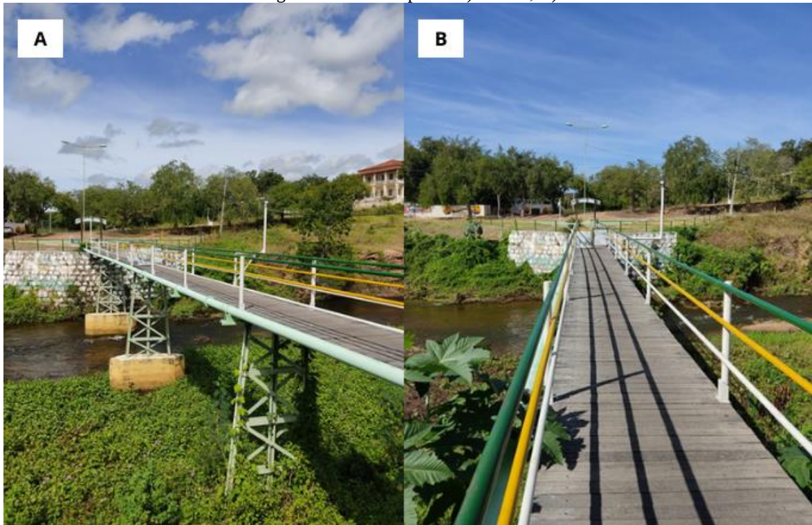
Figura 21: Vista da ponte A) Lateral; B) Frontal.
