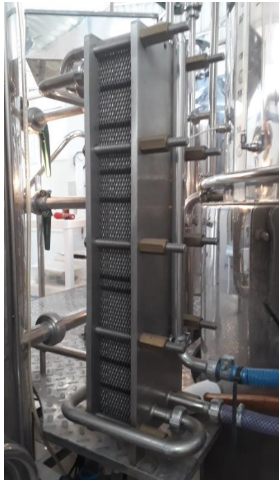
Figura 4: Trocador de calor por placas
