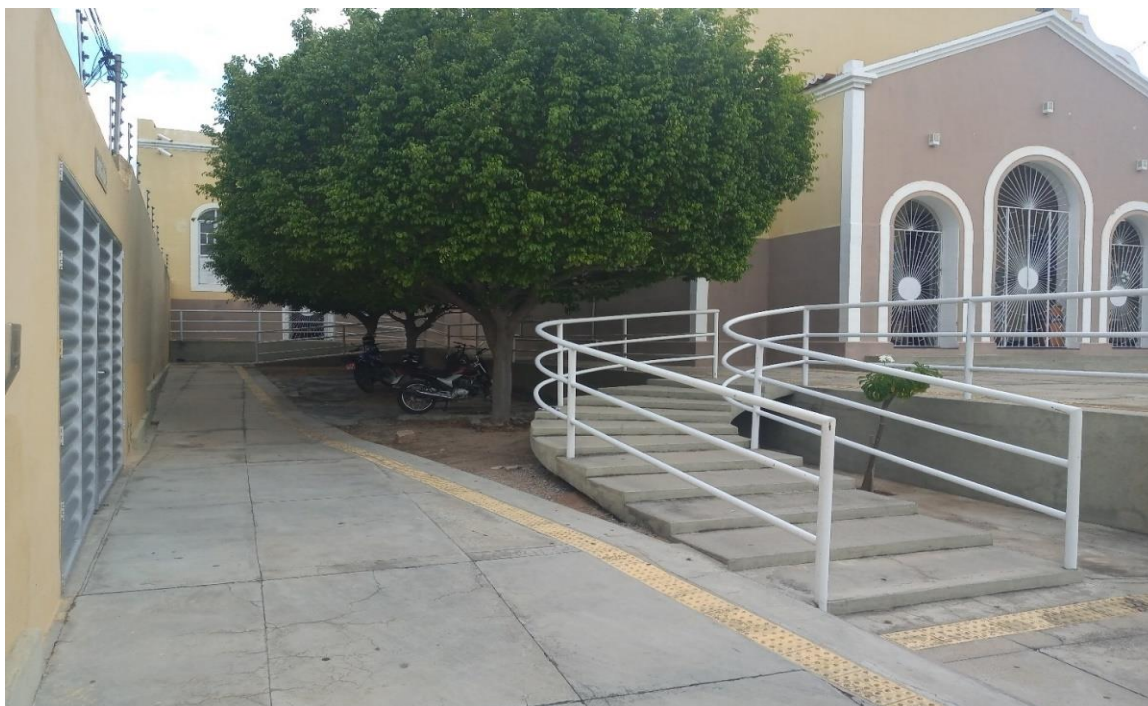
Figura 5: Escadaria localizada na lateral esquerda do centro religioso “A”
