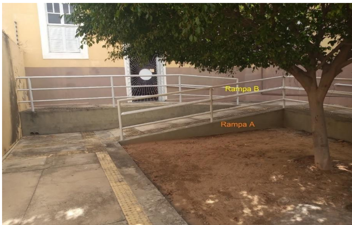
Figura 4: Rampa localizada na lateral esquerda do centro religioso “A”
