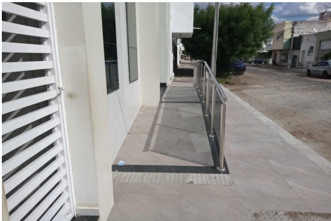
Figura 7: Rampa de acesso do centro religioso “B”
