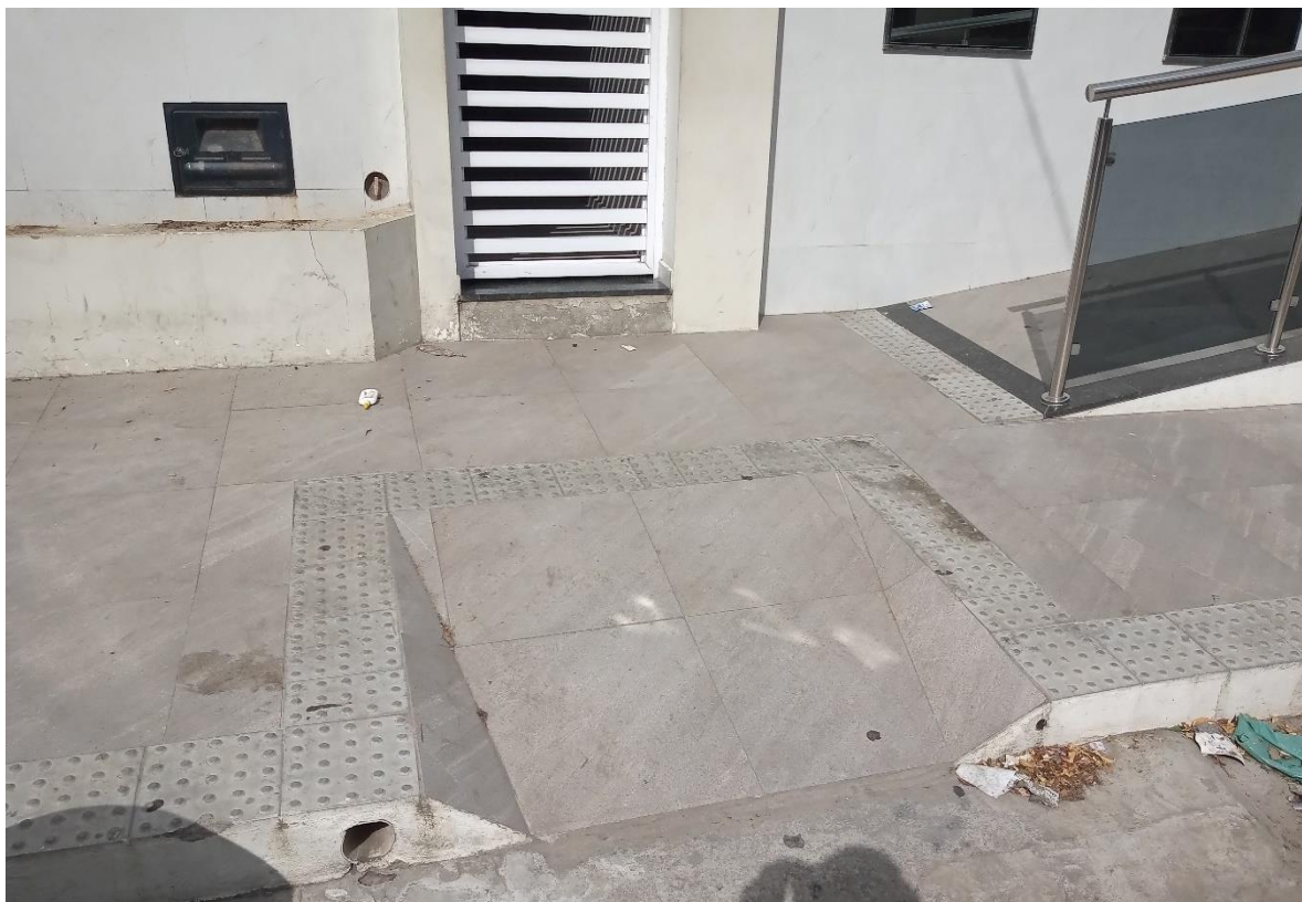
Figura 8: Rampa de acesso do centro religioso “B”
