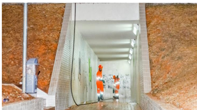
Figura 6 - Passarela sobrejacente em Brasília
