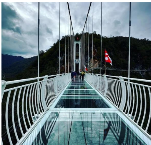
Figura 2 - Passarela Bach Long Bridge
