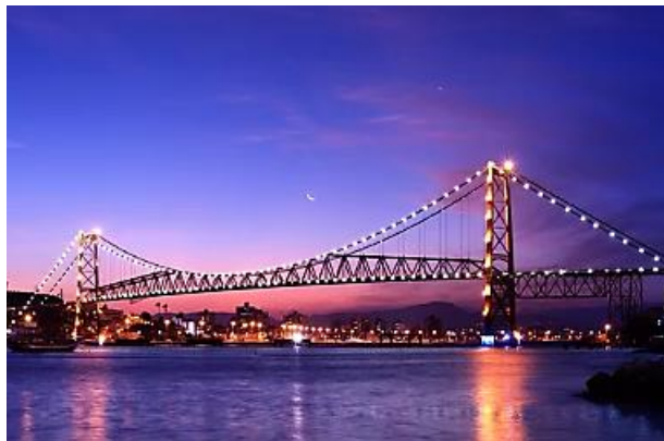
Figura 10 - Ponte Hercílio Luz
