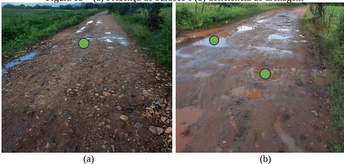
Figura 15 – (a) Presença de buracos e (b) deficiência de drenagem
