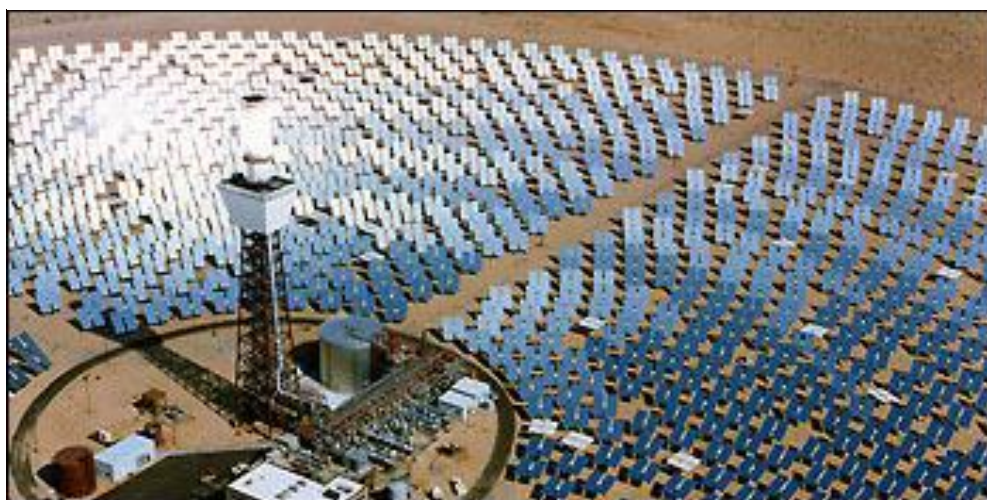
Figura 5. Gerador solar tipo torre two.
