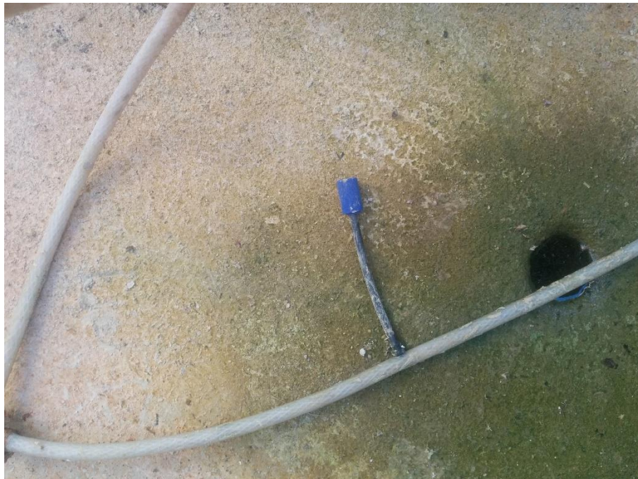
Figura 07: Sistema de aeração no reator aeróbio
