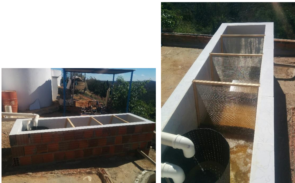
Figura 05: Sistema de gradeamento da ETEI
