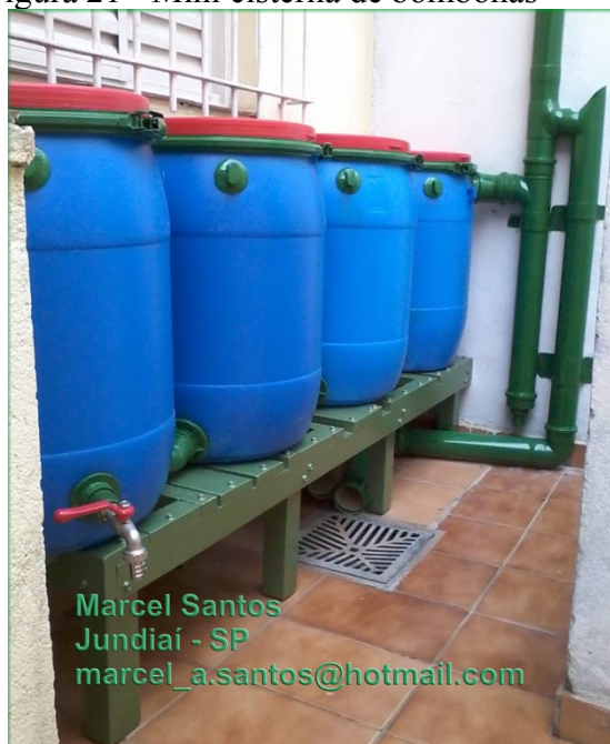
Figura 21 - Mini cisterna de bombonas
