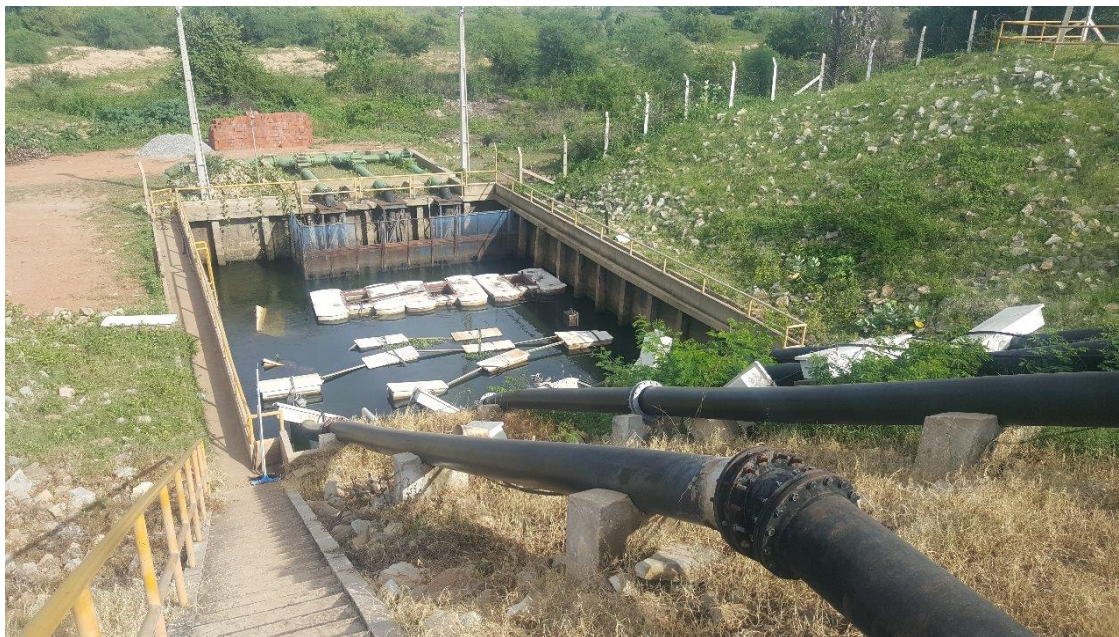
Figura 11 – Canal de derivação na Barragem Engenheiro Armando Ribeiro Gonçalves
