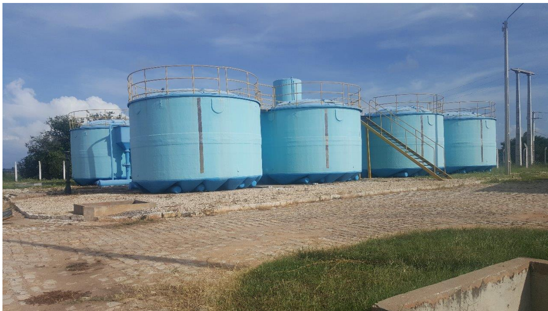
Figura 12 – Estação de Tratamento de água do sistema adutor de Mossoró
