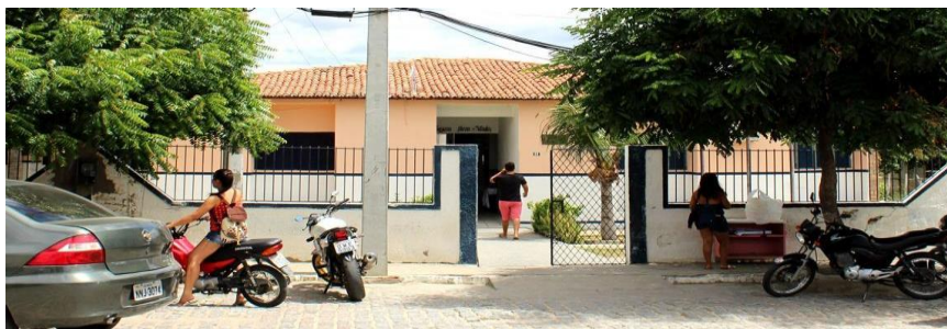
Figura 7 - Fachada atual da escola de pesquisa Fonte: Arquivo pessoal (2024).
