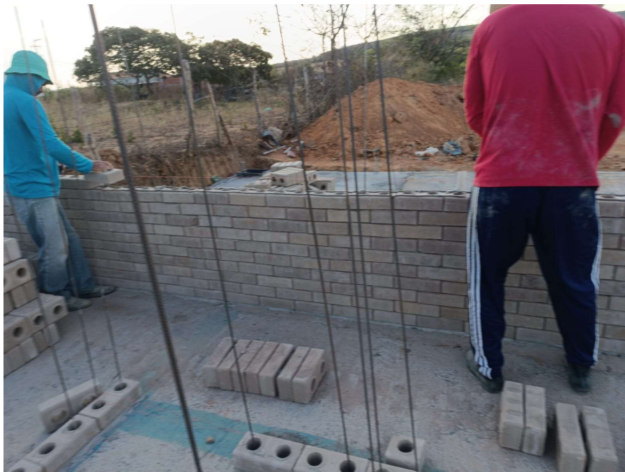
Figura 5: Sistema de alvenaria estrutural com tijolos ecológicos.
