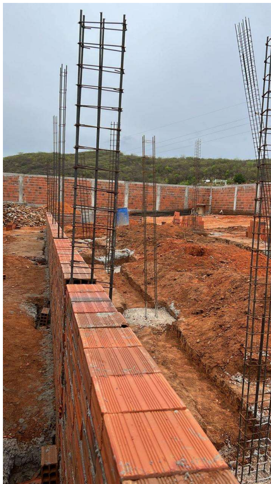
Figura 1: Obra com alvenaria de cerâmica na cidade de São Miguel-RN
