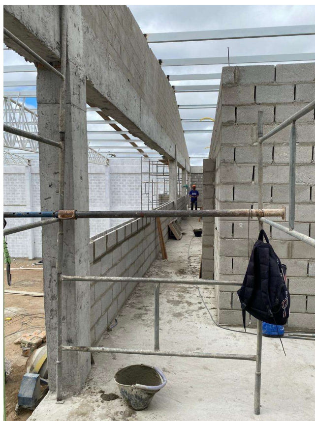
Figura 2: Obra erguida com alvenaria de concreto, sem função estrutural, na cidade de Parnamirim-PE
