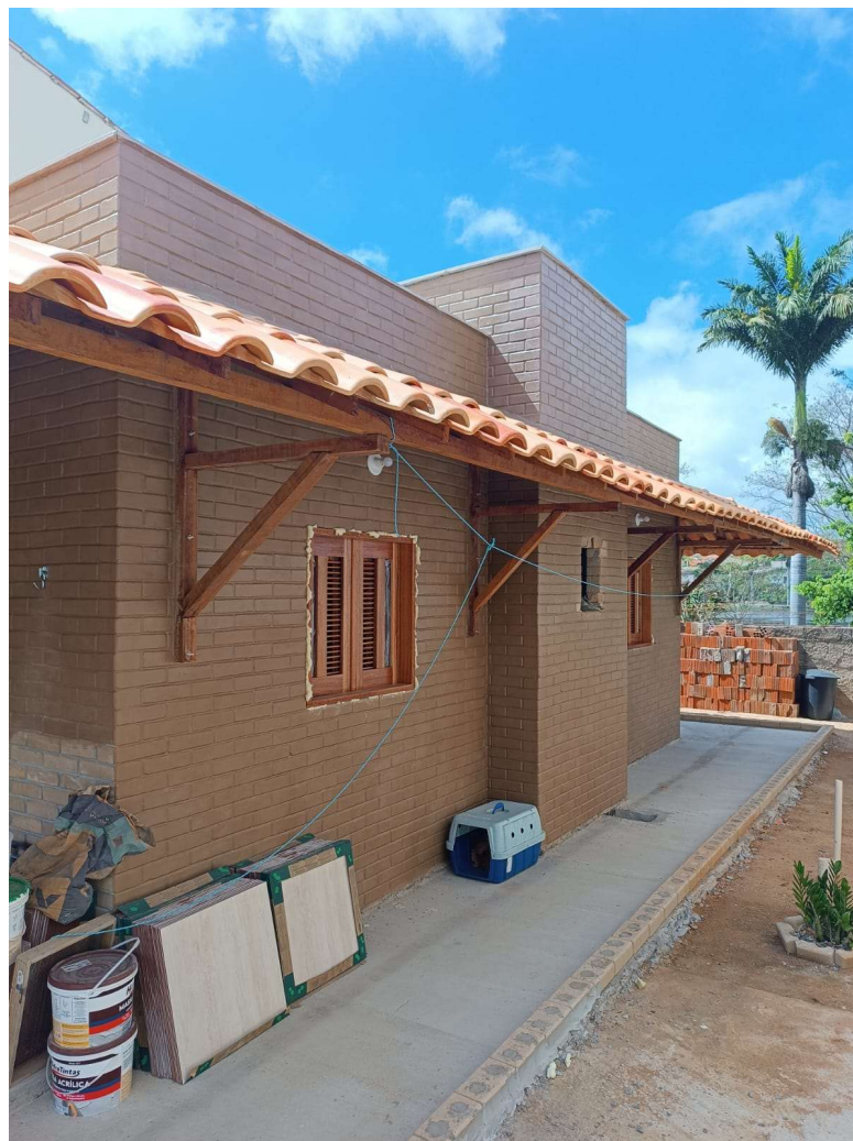
Figura 3: Obra com tijolos ecológicos em fase de acabamento na cidade de São Miguel-RN.
