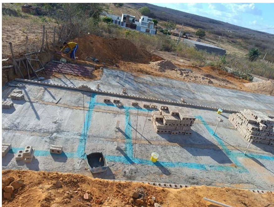
Figura 6: Fundação do tipo radier, para execução de alvenaria com tijolos ecológicos.
