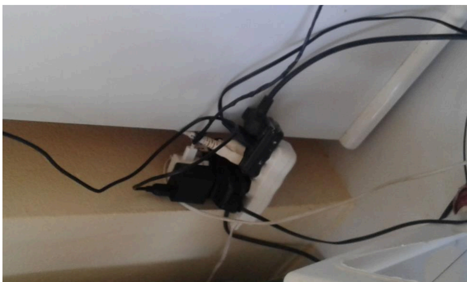
Figura 8: Esquema de sobrecarga na tomada, fazendo-se o uso de “T”
