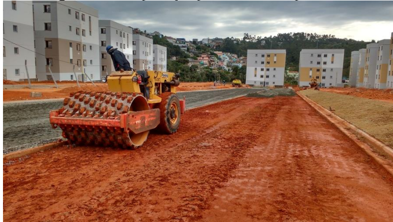
Figura 6 – Compactação para receber um pavimento
