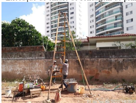
Figura 9 - Execução do ensaio de sondagem do primeiro furo.
