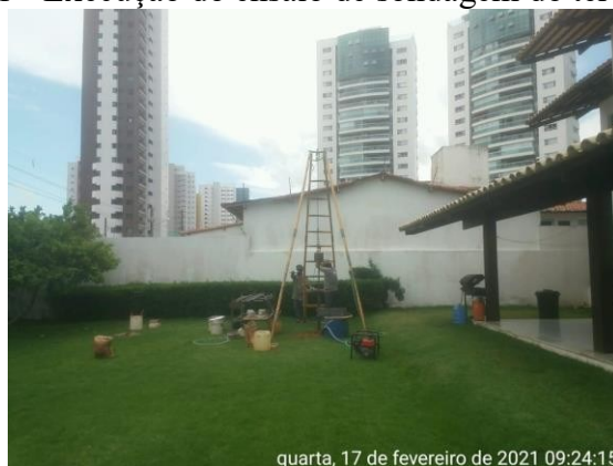
Figura 11 - Execução do ensaio de sondagem do terceiro furo.
