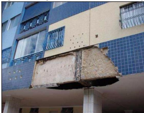
Figura 23. Desplcamento localizado do emboço
