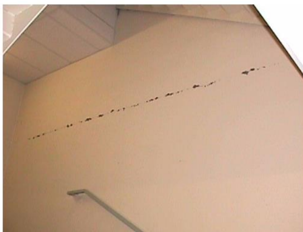
Figura 18. Fissuras horizontais
