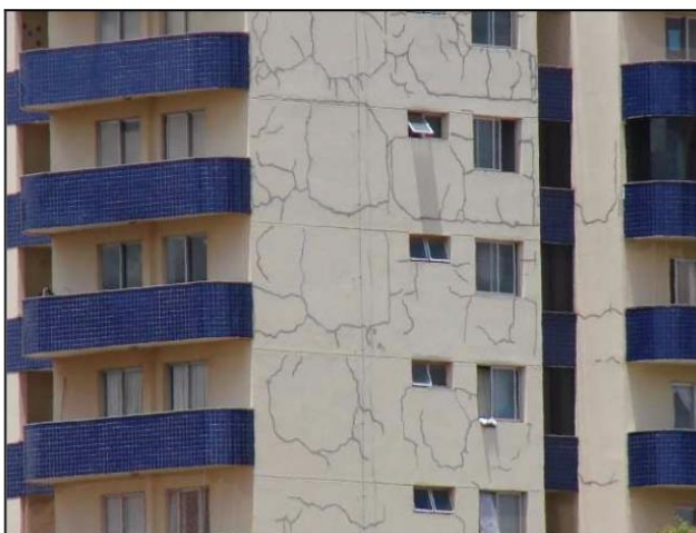
Figura 17. Fissuras Mapeadas
