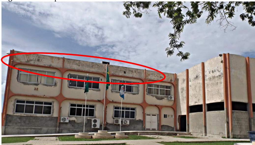
Figura 27. Vista parcial da fachada frontal
