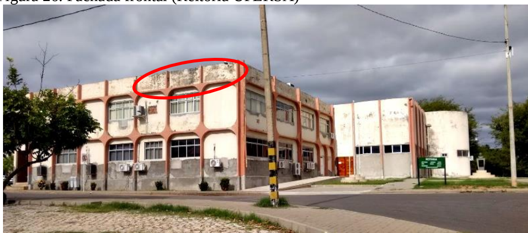
Figura 26. Fachada frontal (Reitoria UFERSA)
