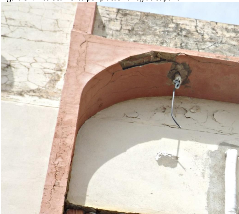
Figura 37. Deslocamento por placas na região superior
