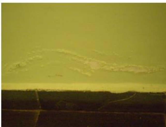
Figura 15. Vesículas em uma parede
