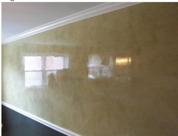
Figura 5. Revestimento barra lúcida.
