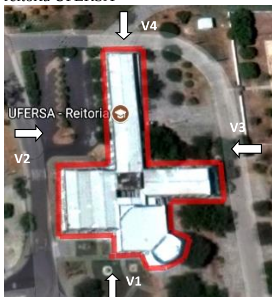
Figura 25. Vista superior do prédio da reitoria UFERSA
