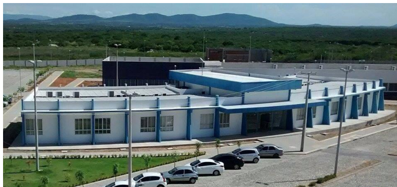
Figura 12: Prédio administrativo da UFERSA Campos Pau dos Ferros
