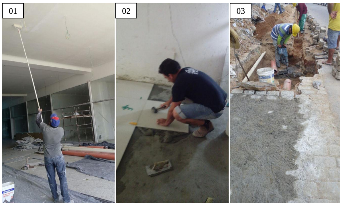
Figura 03 – Atividades analisadas na obra 02
