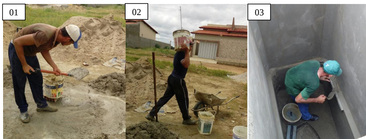
Figura 06 – Atividades analisadas na obra 04
