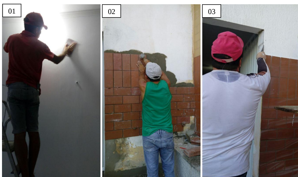
Figura 02 – Atividades analisadas na obra 01
