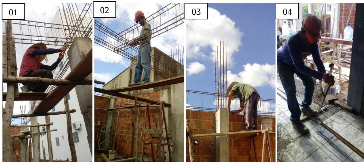
Figura 04 – Atividades analisadas na obra 03
