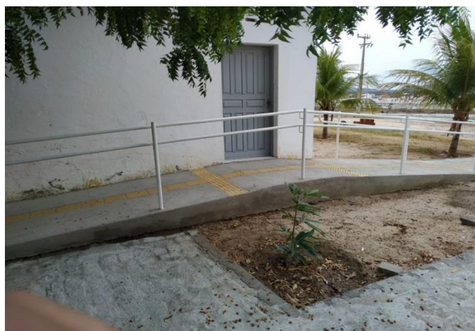
Figura 28 – Rampa de acesso 03 e 04 do Bloco B.
