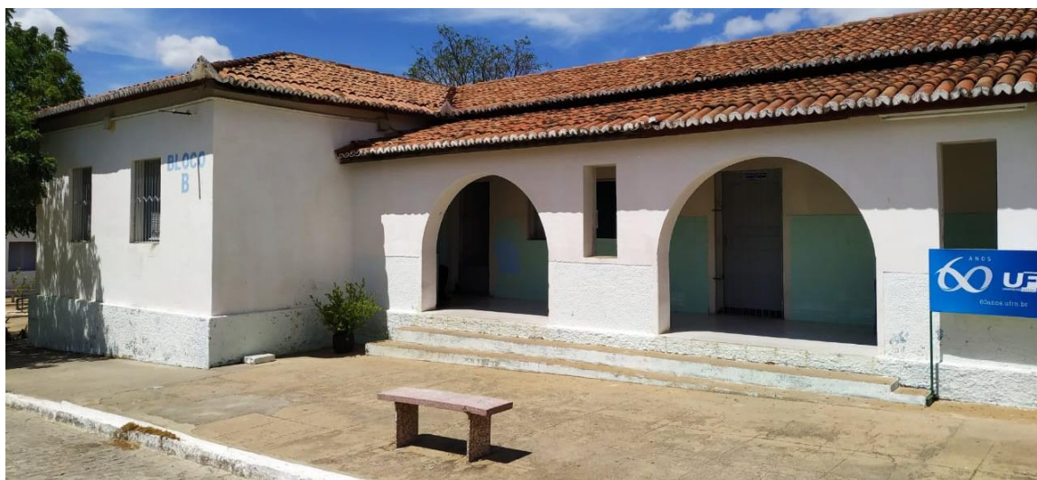
Figura 29 – Escada de acesso Bloco B.
