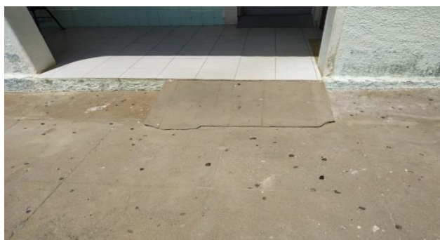
Figura 26 – Rampa de acesso 01 do Bloco B.
