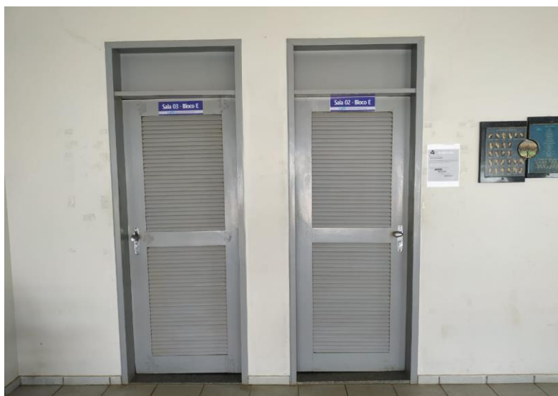
Figura 19 – Portas das salas das aulas do Bloco E.
