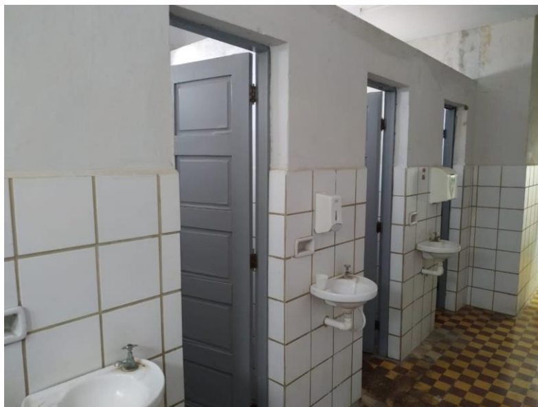
Figura 33 – Porta dos boxes dos banheiros do Bloco A.
