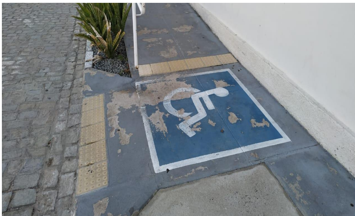
Figura 12 – Rebaixamento de calçada 1 do Bloco C.
