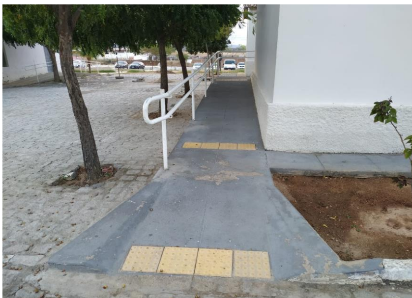
Figura 15 – Rebaixamento de calçada 2 do Bloco C.
