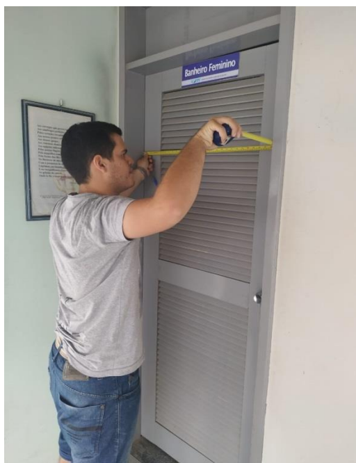
Figura 21 – Porta dos banheiros do Bloco E.
