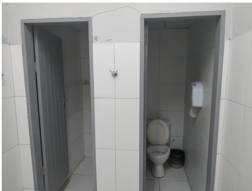
Figura 24 – Detalhes dos boxes dos banheiros do Bloco Administrativo.
