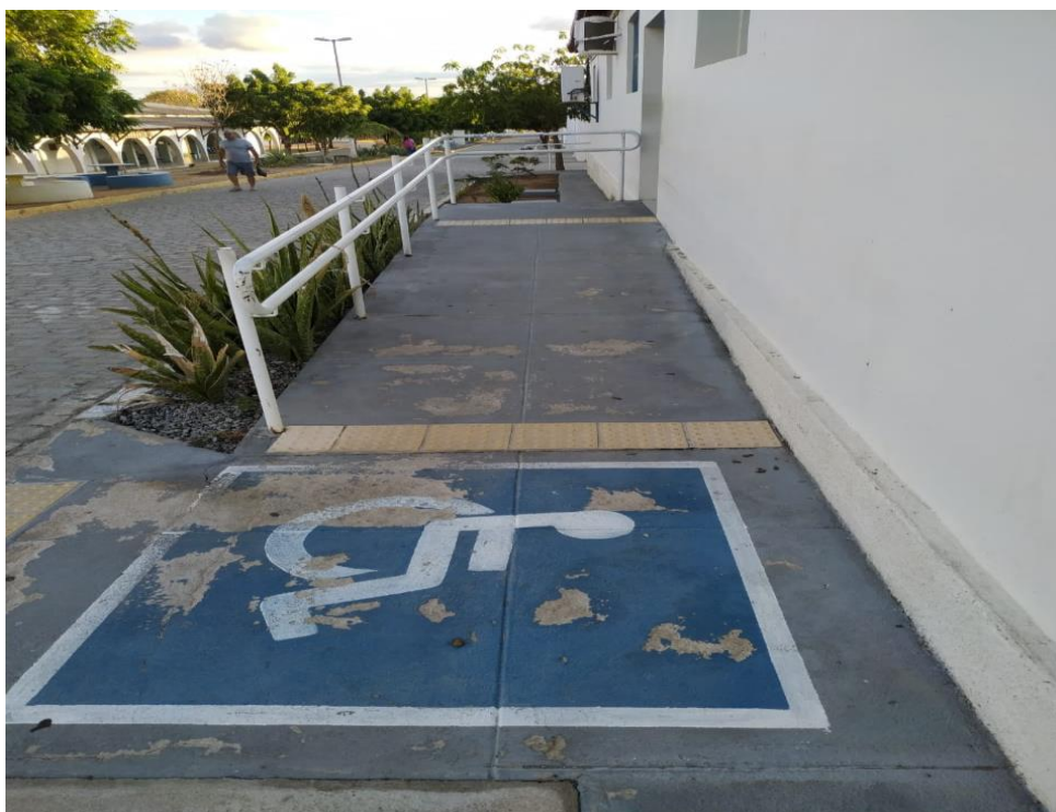
Figura 11 – Rampa de acesso 1 do Bloco C.
