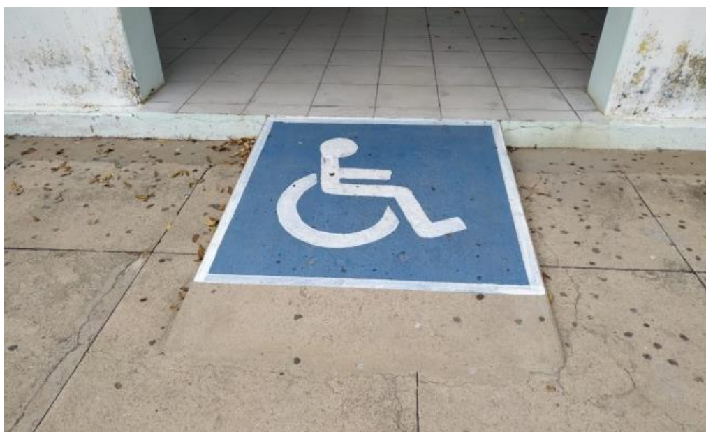
Figura 31 – Rampa de acesso 01 do Bloco C.
