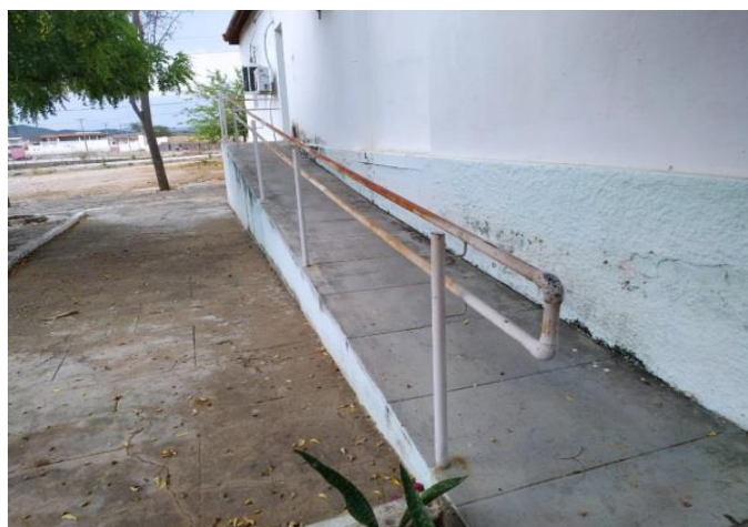
Figura 27 – Rampa de acesso 02 do Bloco B.
