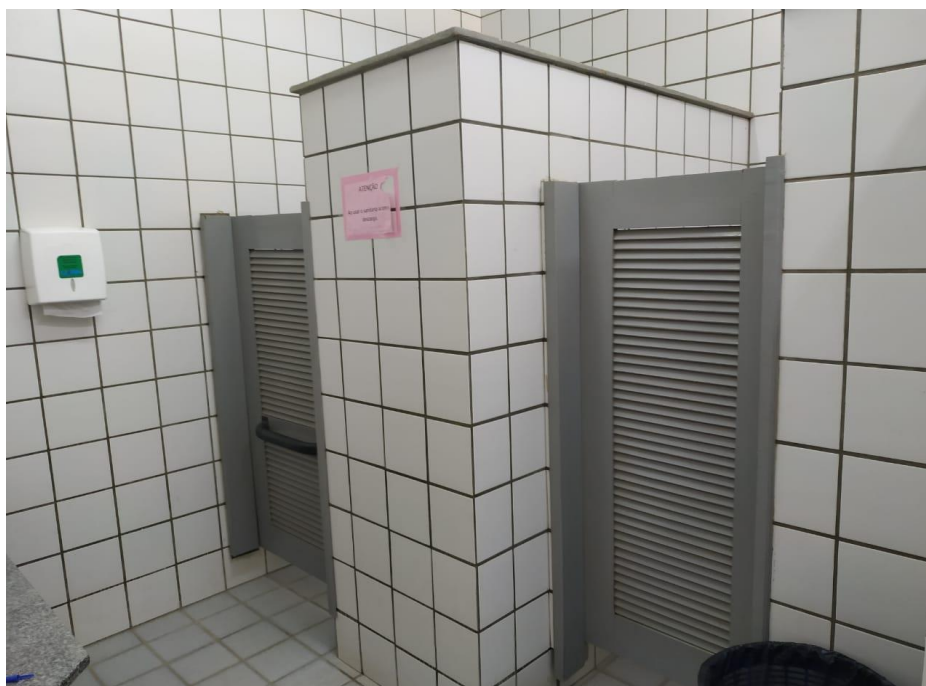
Figura 20 – Divisão dos boxes dos banheiros do Bloco E.
