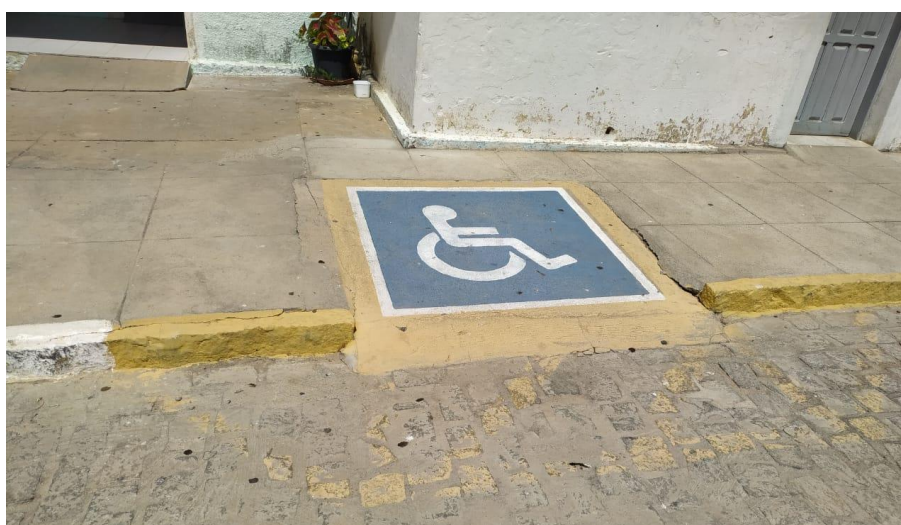
Figura 25 – Rebaixamento de calçada 1 do Bloco B.
