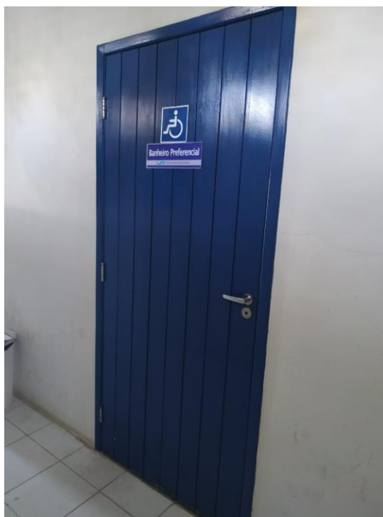
Figura 18 – Porta do banheiro adaptado do Bloco C.
