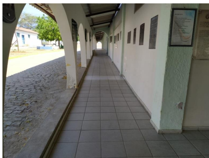
Figura 23 – Rampa de acesso 1 do Bloco Administrativo.
