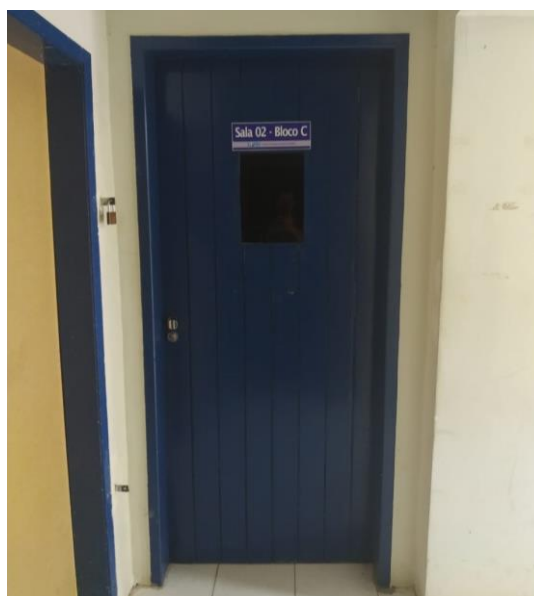
Figura 16 – Portas das salas das aulas do Bloco C.
