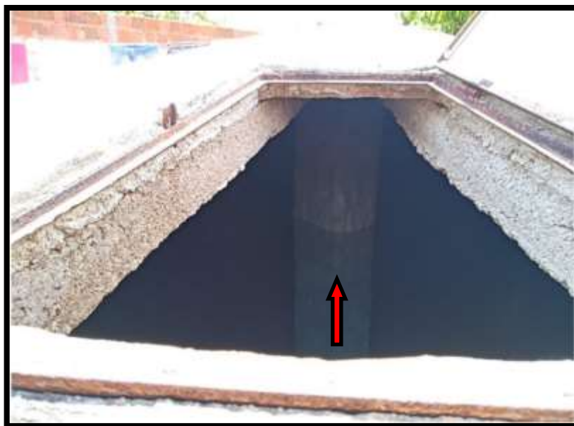
Figura 9 – CISTERNA DE PLACA CONTENDO PILAR NO CENTRO
