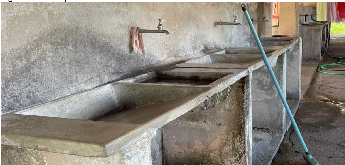
Figura 11 - Tanques de concreto
