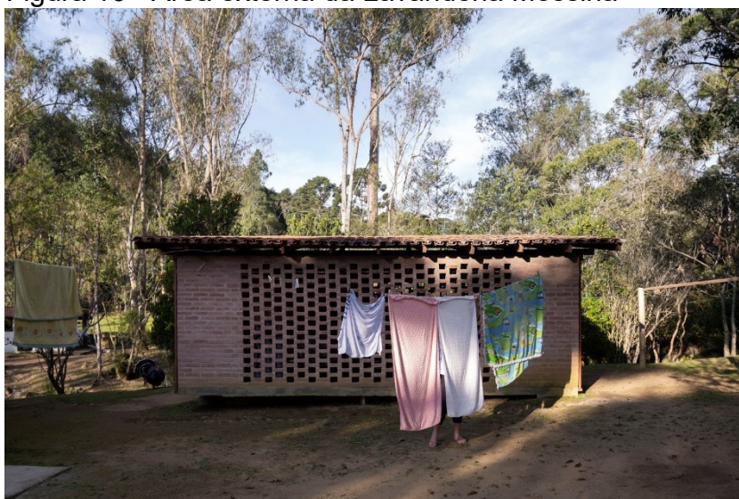
Figura 16 - Área externa da Lavanderia Messina
