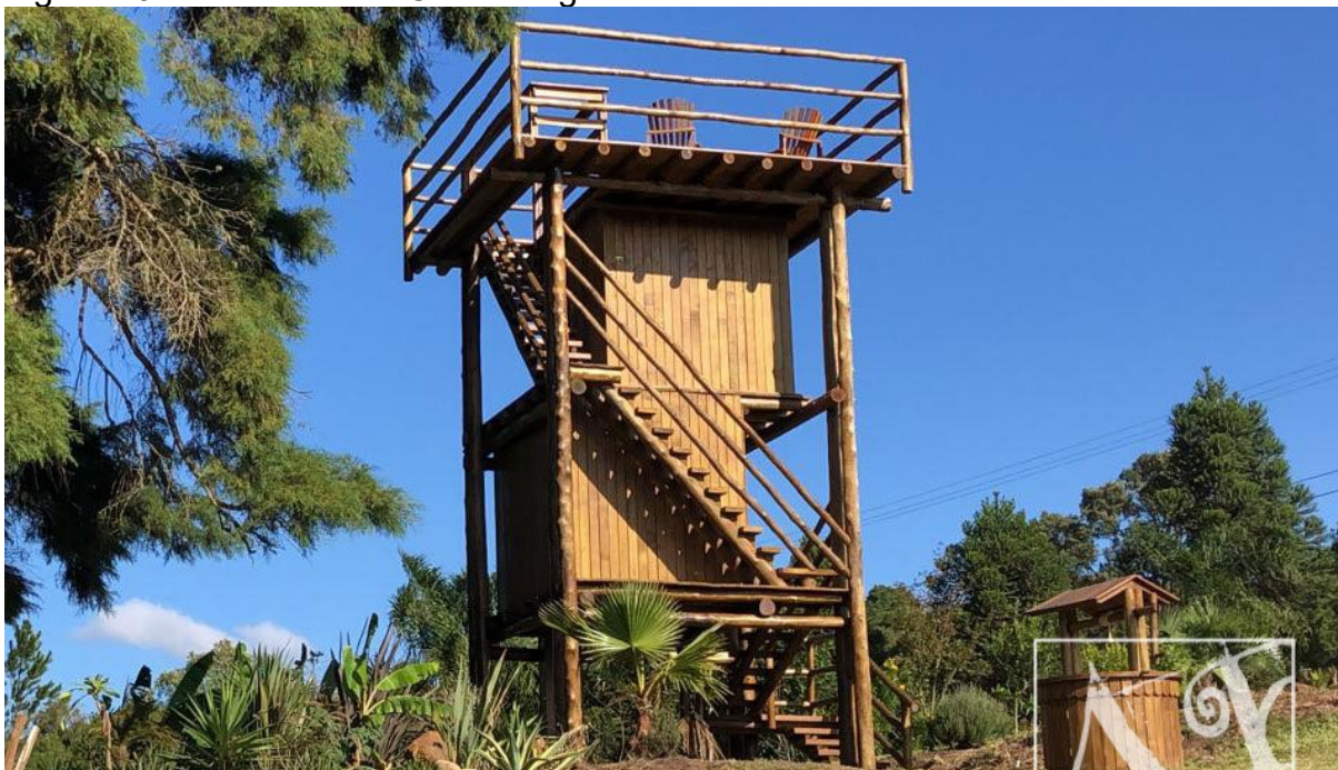
Figura 29 - Torre Mirante Caixa D'água
