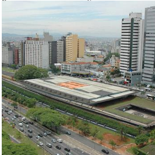
Figura 2: Centro Cultural Vergueiro.
