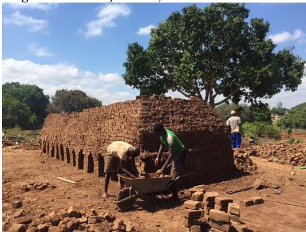
Figura 42: Confecção dos tijolos do edifício
