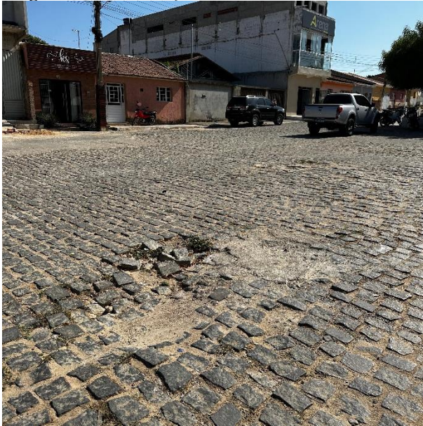
Figura 24: Pavimentação da entrada do bairro
