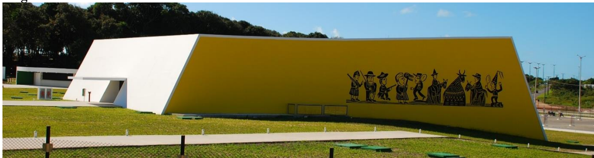
Figura 49: Auditório fachada lateral e acesso
