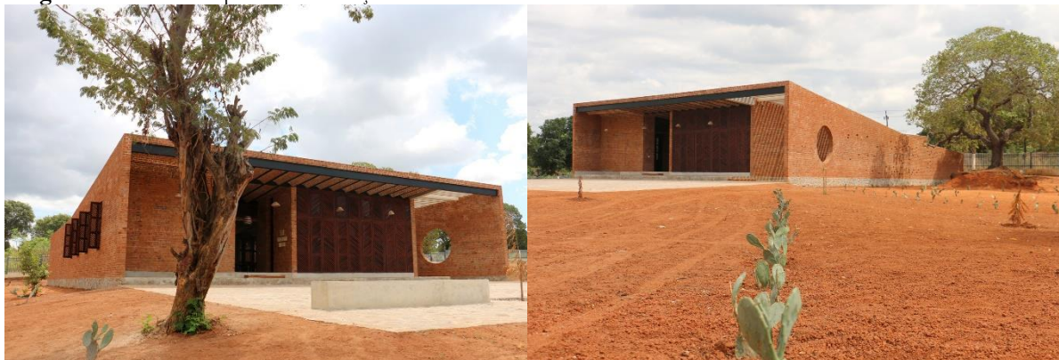
Figura 44: Visão completa da edificação.
