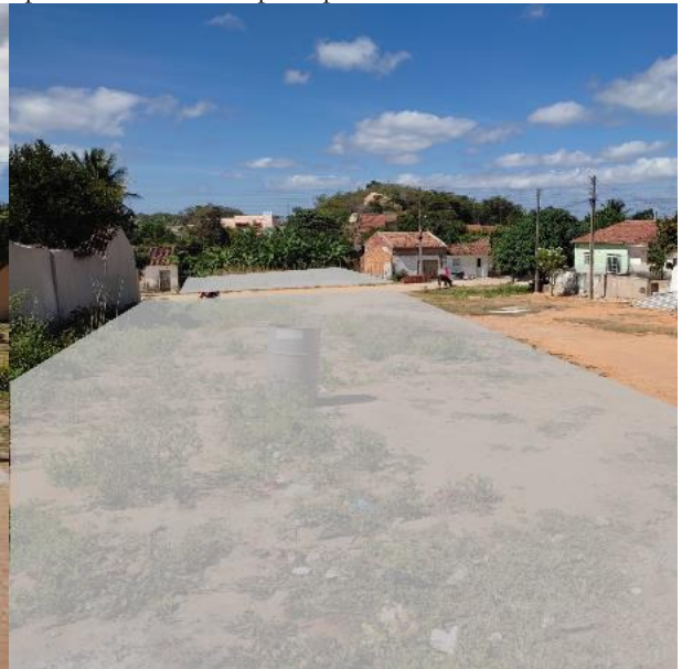
Figura 9: Visão geral dos terrenos analisados, primeiro plano terreno bloco principal
