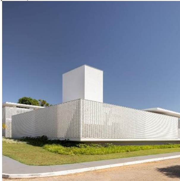
Figura 45: Fachadas principal em tijolos brancos como elemento vazado
