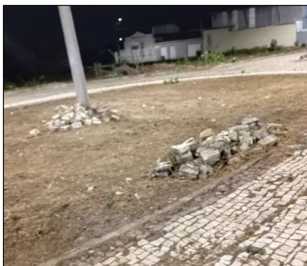
Figura 3: Despejos de RCC no canteiro da avenida principal do Cidade Oeste.
