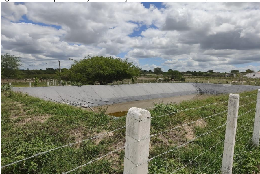
Figura 14: Estação de Rejeito do Poço Artesiano. Brasilinha, Ouro Branco/AL.
