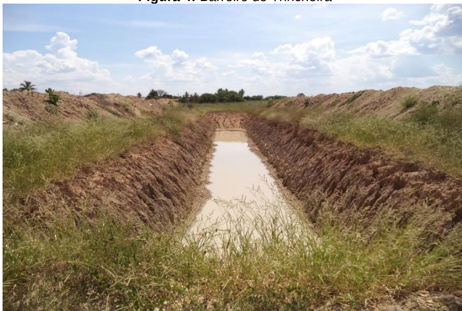
Figura 4: Barreiro de Trincheira
