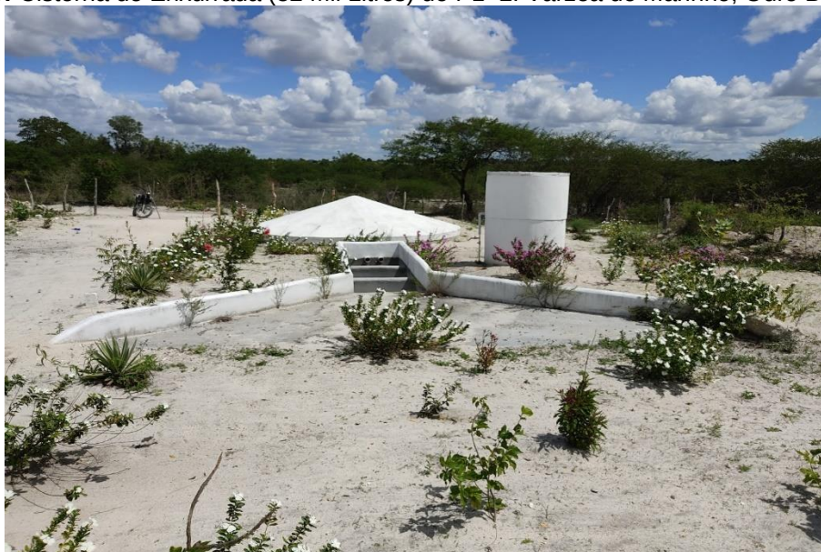
Figura 9: Cisterna de Enxurrada (52 Mil Litros) do P1+2. Várzea do Marinho, Ouro Branco/AL.
