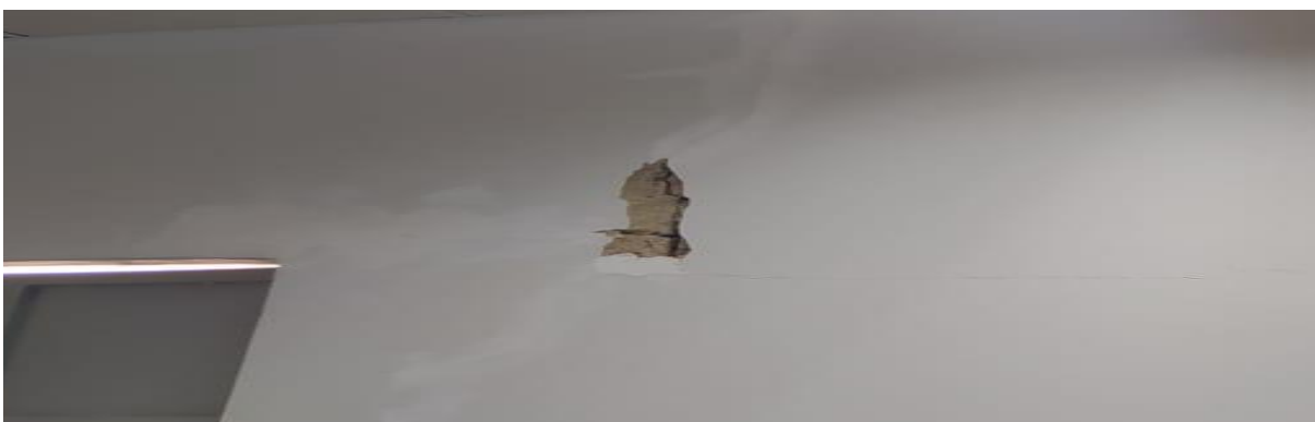
Figura 65 – Armadura Exposta no Acervo Geral
