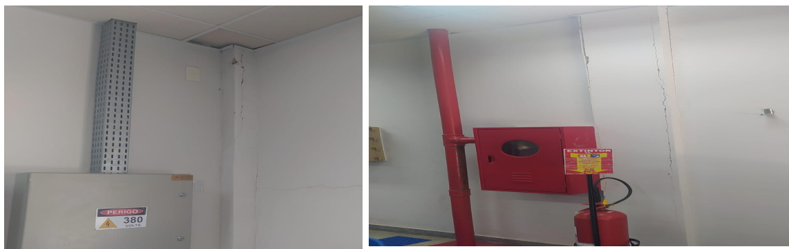
Figura 61 – Fissura vertical em pilar interno no Hall de Entrada
