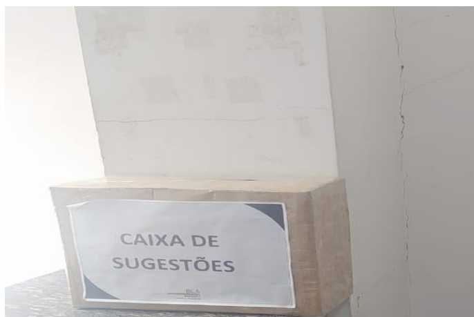
Figura 63 – Fissura horizontal em pilar do Guarda Volume
