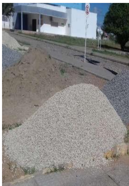
Figura 1 – Depósito da areia e da brita utilizada
