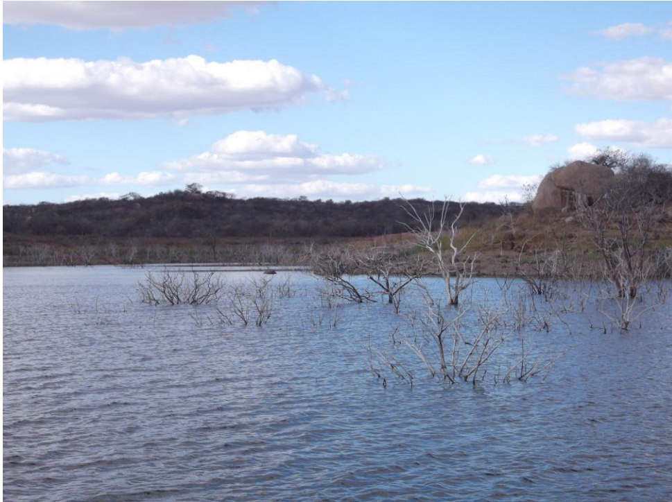
Figura 10. Visão geral do ponto 7 (Compartimento Fluvial), no reservatório de Santa Cruz – Apodi/RN.
