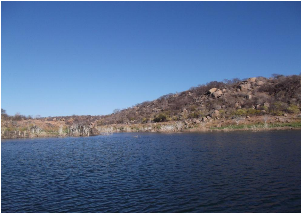
Figura 8. Visão geral do ponto 5 (Compartimento Transição), no reservatório de Santa Cruz – Apodi/RN.
