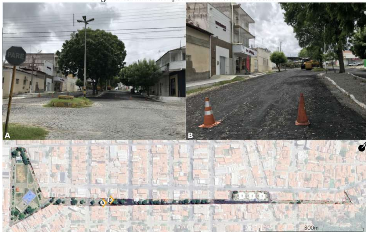
Figura 23- Pavimentação asfáltica no dia 29 de abril
