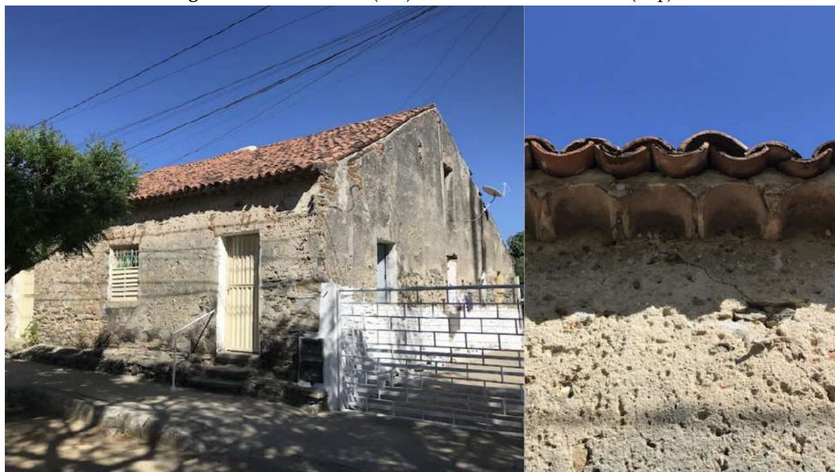
Figura 6- Casa de Pedra (dir.) e detalhe da beira-seveira (esq.)
