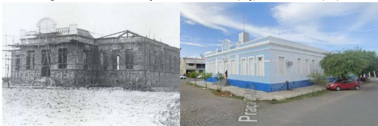
Figura 9- Construção do Grupo S. Guerra 1922-1924 (esq.) e nos dias atuais (dir.)
