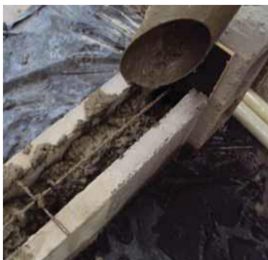
Figura 15: Preenchimento com graude (CONTADINI, 2014).
