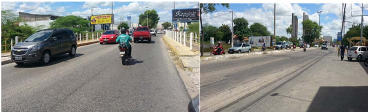
Figura 15: Vista da ponte próxima ao segundo ponto de medição.
