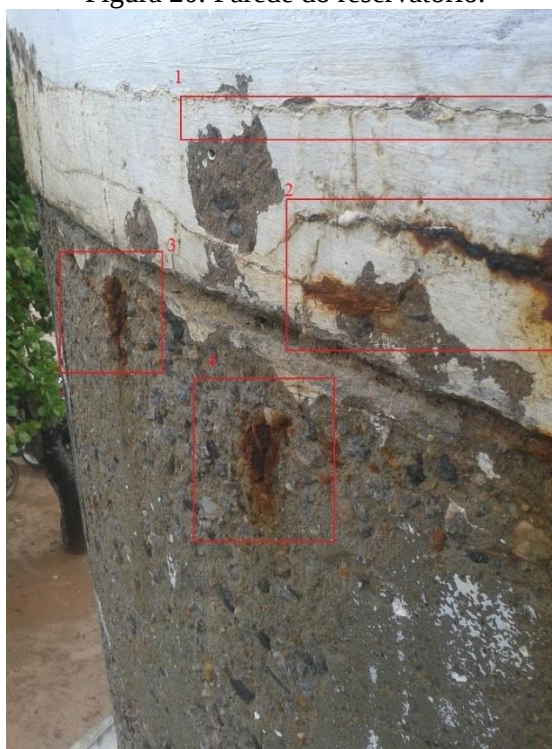
Figura 20: Parede do reservatório.
