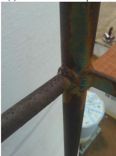
Figura 19 (b): Escada de acesso ao topo do reservatório.
