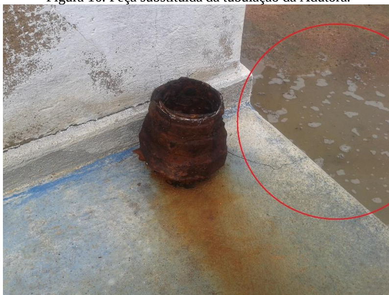
Figura 16: Peça substituída da tubulação da Adutora.
