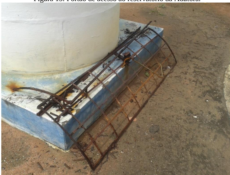
Figura 15: Portão de acesso ao reservatório da Adutora.
