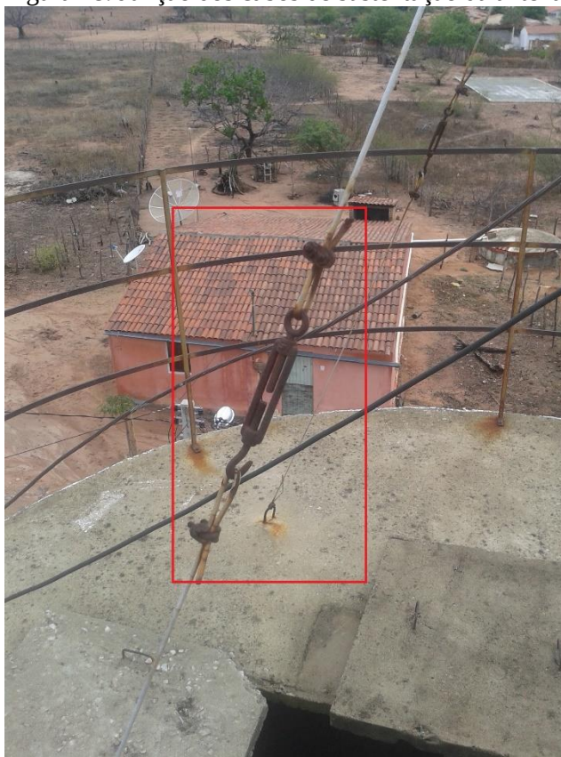
Figura 18: Junção dos cabos de sustentação da antena.
