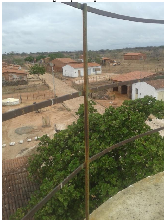
Figura 17: Grades de segurança do topo do reservatório da Adutora.
