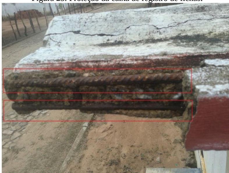
Figura 23: Proteção da caixa de registro de fichas.
