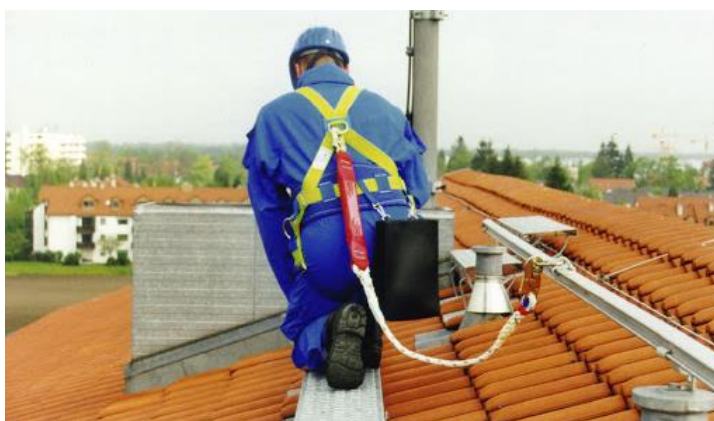
Figura 11: Aplicação de linha de vida horizontal
